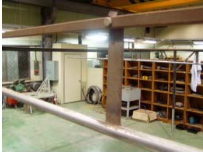
그림 3.2.13 오버헤드 가이드스 레일을 기존 구조물에 연결한 모습.
