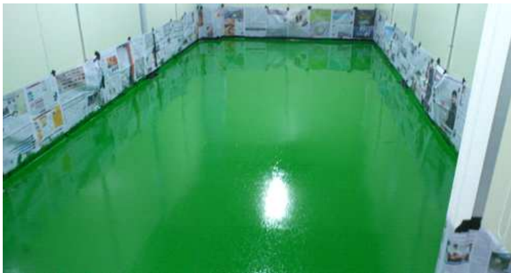
< 바닥재(에폭시 코팅) 시공 >
