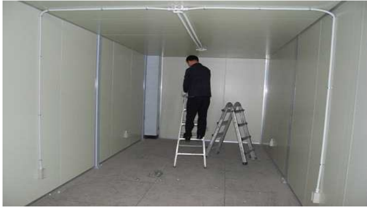
< 재배실 시공 및 전기 배선 >
