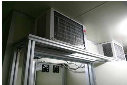
< 창문형냉방기 내부(좌)와 외부(우)의 설치 >
