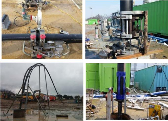
그림 4-5 Inner Pipe 안정적 시공기술 확보(Butt fusion & Centralizer)
