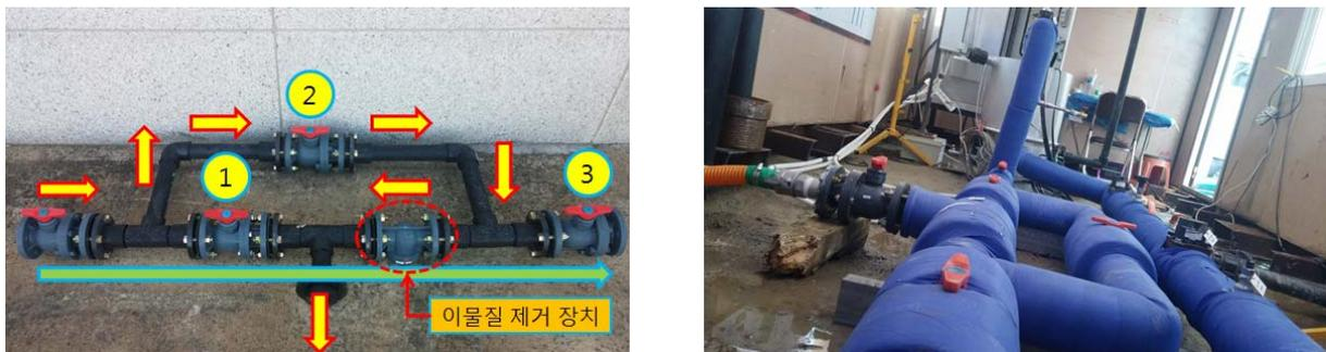
그림 3-86 이물질 제거 장치 설치
