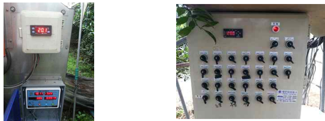
그림 15. 온실제어장치에 부착되어 사용되는 온도측정
