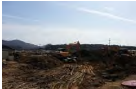
가스 및 침출수 배관 설치후 주변정리
