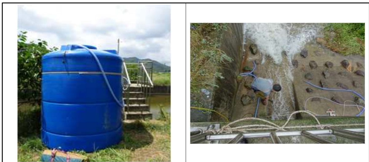
〈그림 5-21〉 응집침강장치(설치예시)
