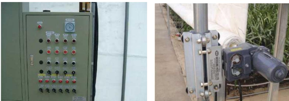
그림 3. 알루미늄 다겹 스크린 설치 (컨트롤박스 및 개폐기)
