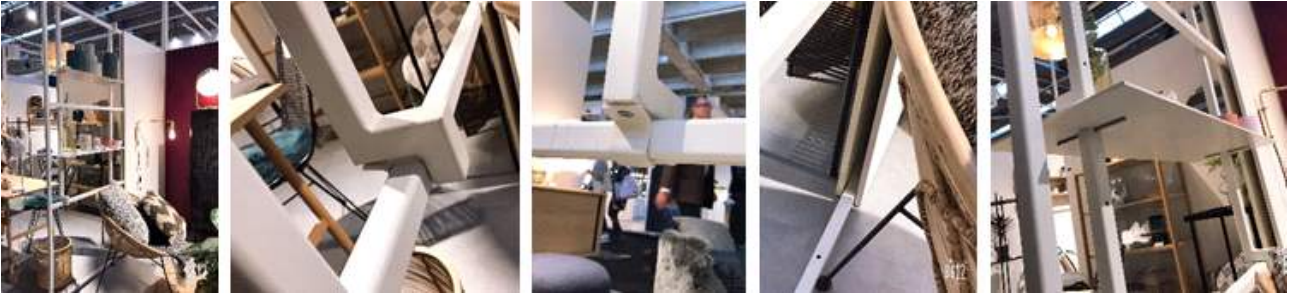
그림 111. 선적, 면적 부재가 하드웨어로 간단히 결합되어 벽 구조물이 되는 사례 2
