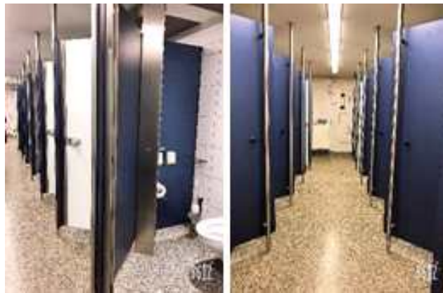
그림 112. 수직 부재 공간 고정 후 면적 부재를 간단히 하드웨어로 고정하여 벽구조가 형성되는 사례
