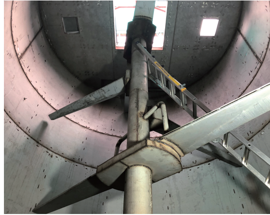
<콤포스트 내부 교반날개 조립>
