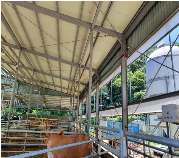
그림. 7 알루미늄메쉬커튼과 2류체 포그시스템을 적용한 개방형 하우스
