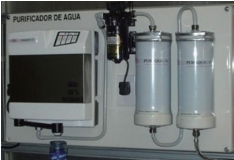
사진 II-1 필터가 설치된 식수 공급 장치
