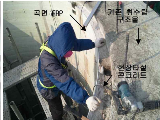
(d) 콘크리트 충전 후 전경
