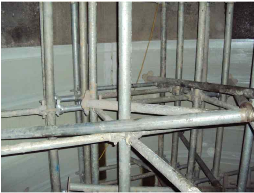
(c) FRP 부재 취수탑 내부 설치
