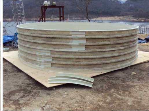
(b) 곡면 FRP 원형 조립
