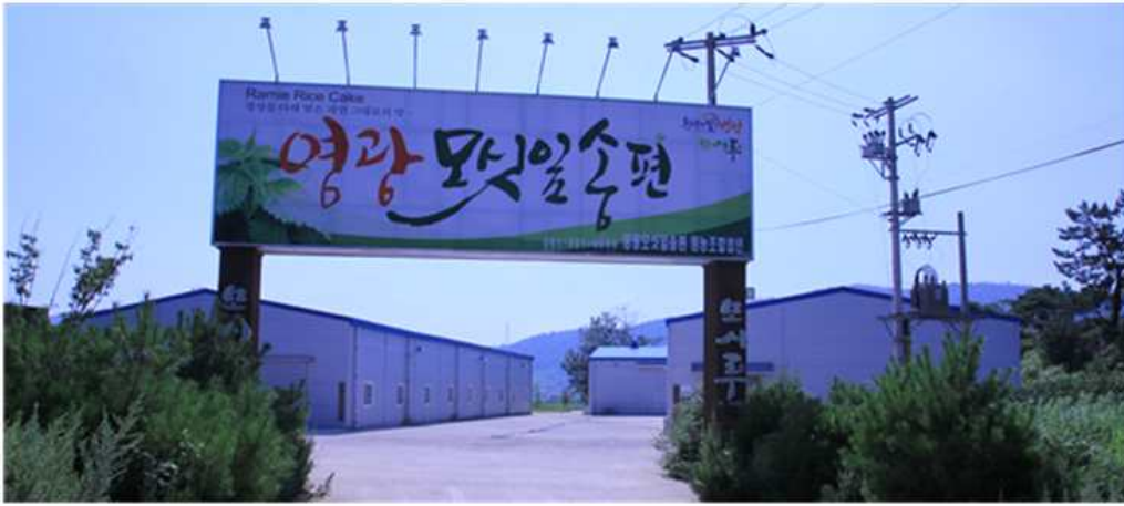
그림 1. 영광모시잇송편영농조합 모시잇가공 시설 전경
