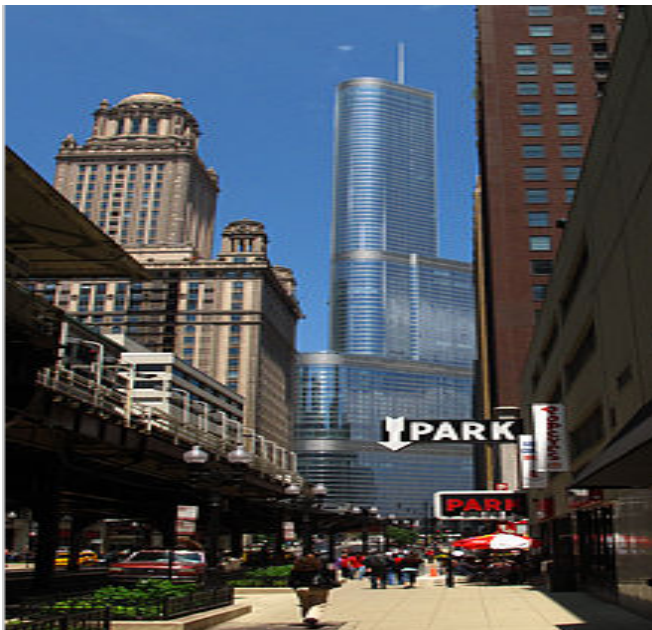
<그림 2-34> 루프(Loop) 지역에 위치한 트럼프 인터내셔널 빌딩
