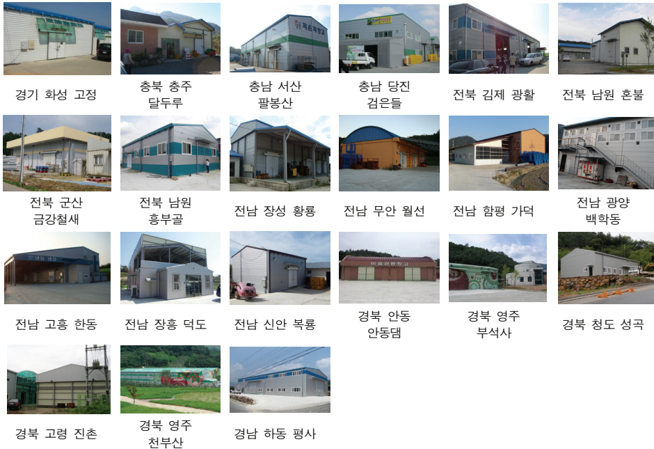
<그림 4-9> 창고시설 전경
