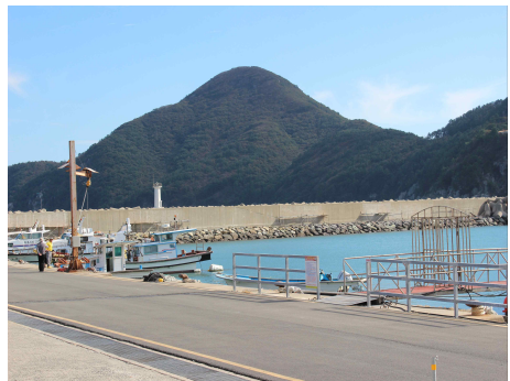
(타일 벽화 공사 준비 중)
