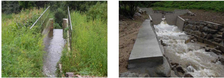
그림 4.3-3 계곡에 설치한 오탍수 방지시설 및 제방·밭 침식 보호시설
