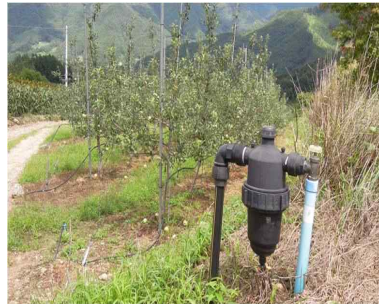
그림 4.3-6 계곡수 취수 집수정 및 사과 밭 관개를 위한 점적호스 및 휠터
