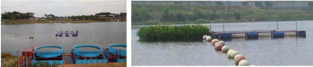
<그림 2.55> cage 이동설치 전·후 모습 (2개조를 각각 분리하여 인공식물섬과 연계 방류배관 연결)
