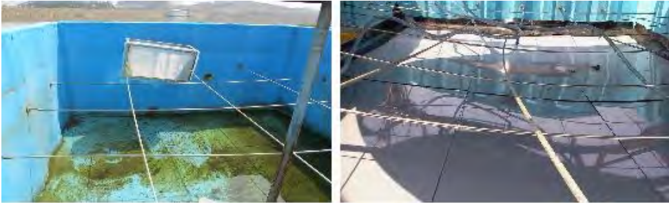
<그림 2.53> 동물플랑크톤 배양조 바닥면 경사판 설치 전(좌), 설치 후(우) 모습
