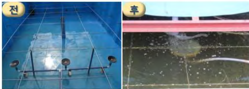
<그림 2.54> 산기관 교체 설치
