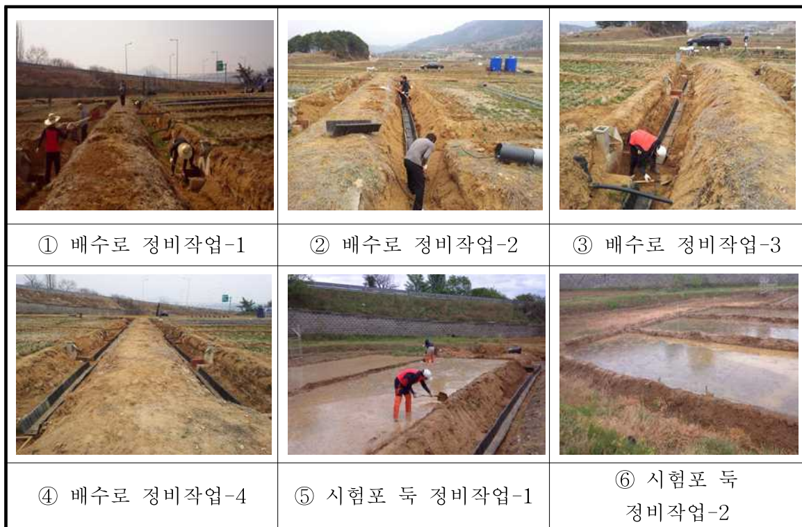
<그림 3-3-1> 둑 및 배수로 정비작업
