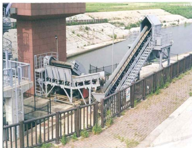
[그림 4.28] 제진기, 벨트 콘베이어 및 호퍼
