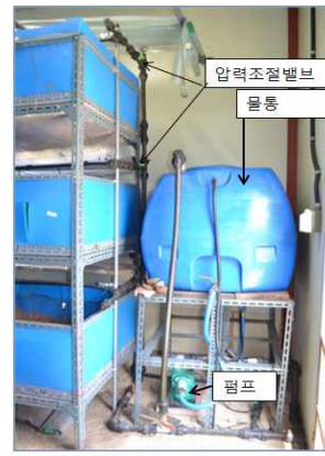
물통, 펌프, 압력조절밸브
