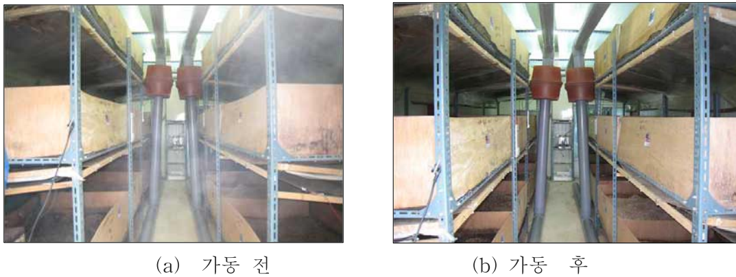
Photo. 2-6 상·하층 온도차 해결과 제습기 기능의 공조기구 개발 시제품 설치 결과.
