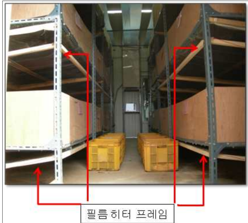
Photo. 3-1 개발 필름히터 난방장치 A동 설치운영 상태
