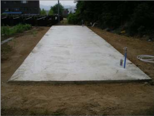
(a) 기초 공사
