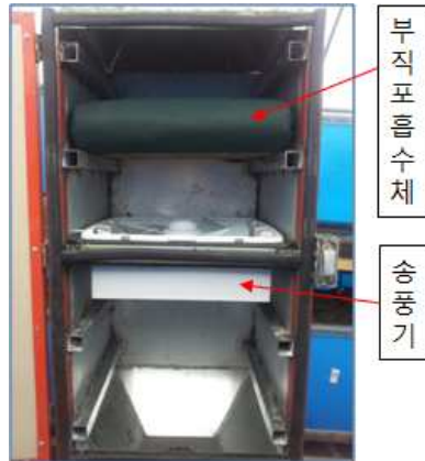
Photo. 1-1 상·하층 온도차 해결과 제습기 기능의 공조기구 설치.
