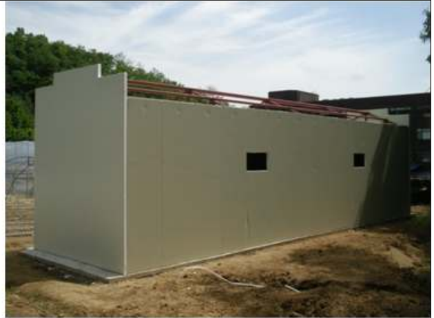
(b) 철골 및 벽면 공사
