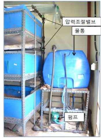
물통, 펌프, 압력조절밸브
