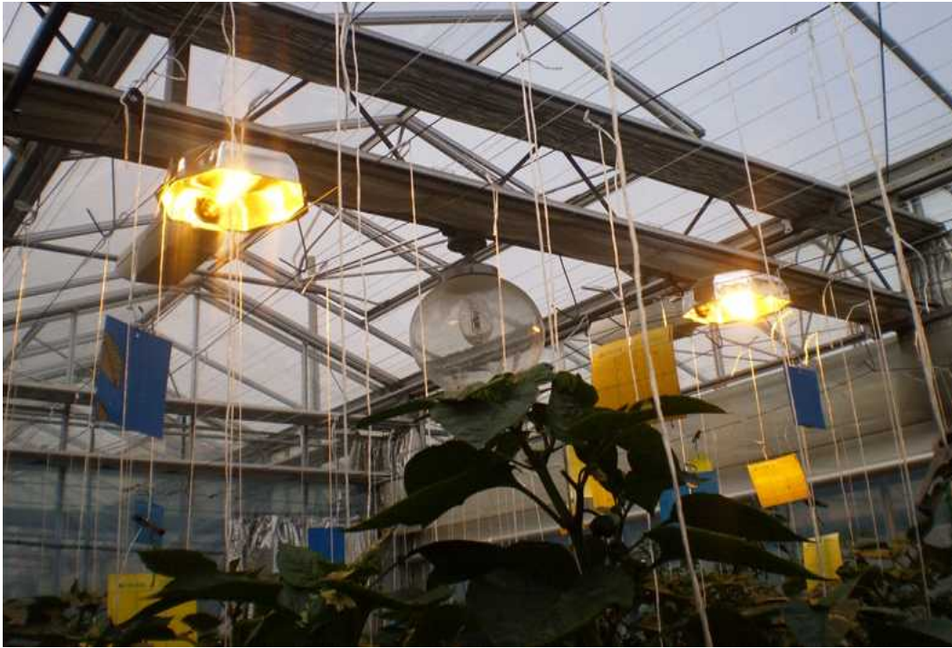
그림 10-1. 파프리카재배 온실내 고압나트륨등을 이용한 보광시스템
