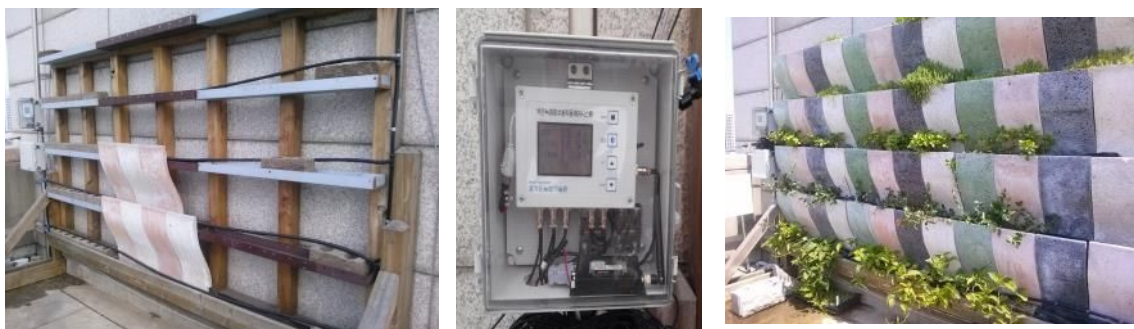
그림 30. 현장실증을 위한 벽면녹화 모듈 설치 및 식물식재
