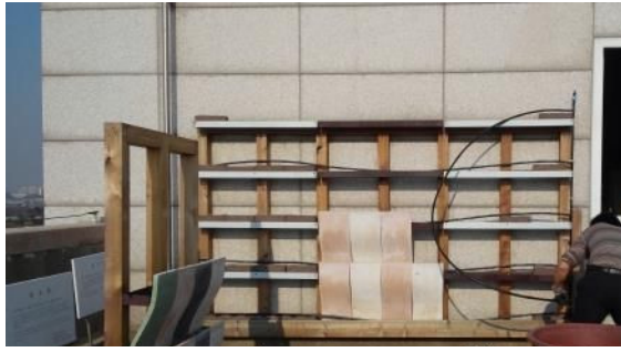
a. 벽면녹화 시스템 설치
