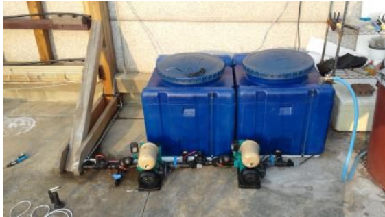
c. 양수분 탱크와 모터 설치
