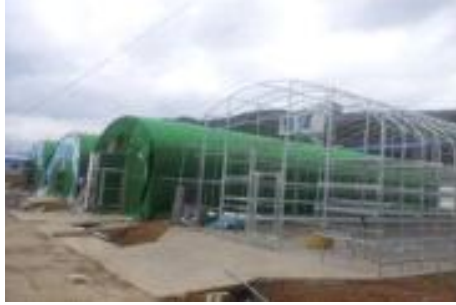
▲ 그림 3.51 복령 연중 재배 하우스 시공.
