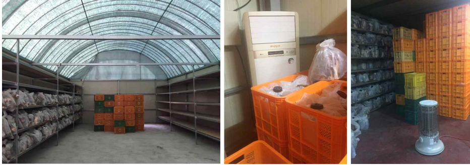
▲ 그림 3.49 재배환경을 만들어 주기 위한 냉·온풍기 및 보조난방용 가스난로의 사진.
