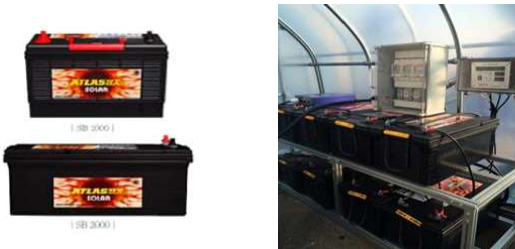
[그림 3-2] 태양광-열 복합시스템으로부터 생산된 전지 저장을 위한 축전지
