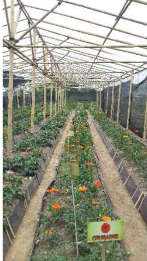
b. 재비 시설 전경
