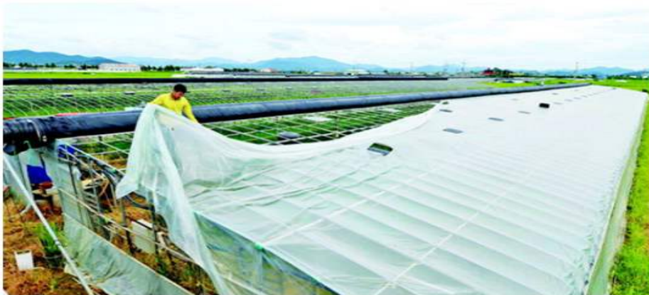
<노후 비닐 교체 작업>
