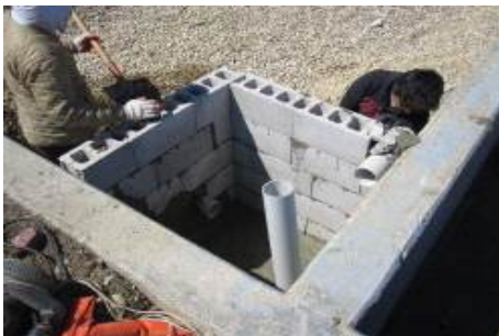
(방류수 배관 조절부 설치)
