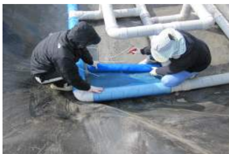
(통기관 보호망 설치)
