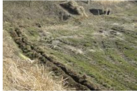
(유입관 매설 터파기)
