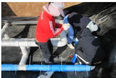
(통기관 보호망 설치)
