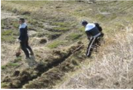
(유입관 매설 터파기)
