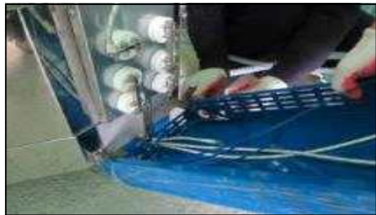
외부 챔버 안전판 설치
