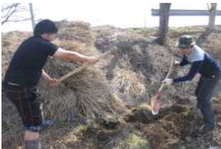
(유입관 매설 터파기)
