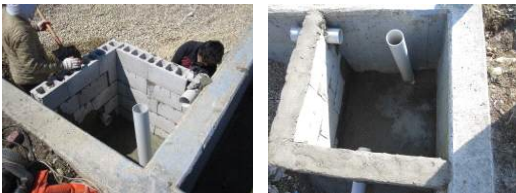
Fig. 3-270. 수위조절이 가능한 혐기성조 배수관 작업.
