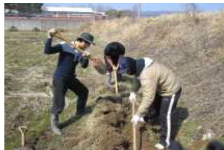
(유입관 매설 터파기)
