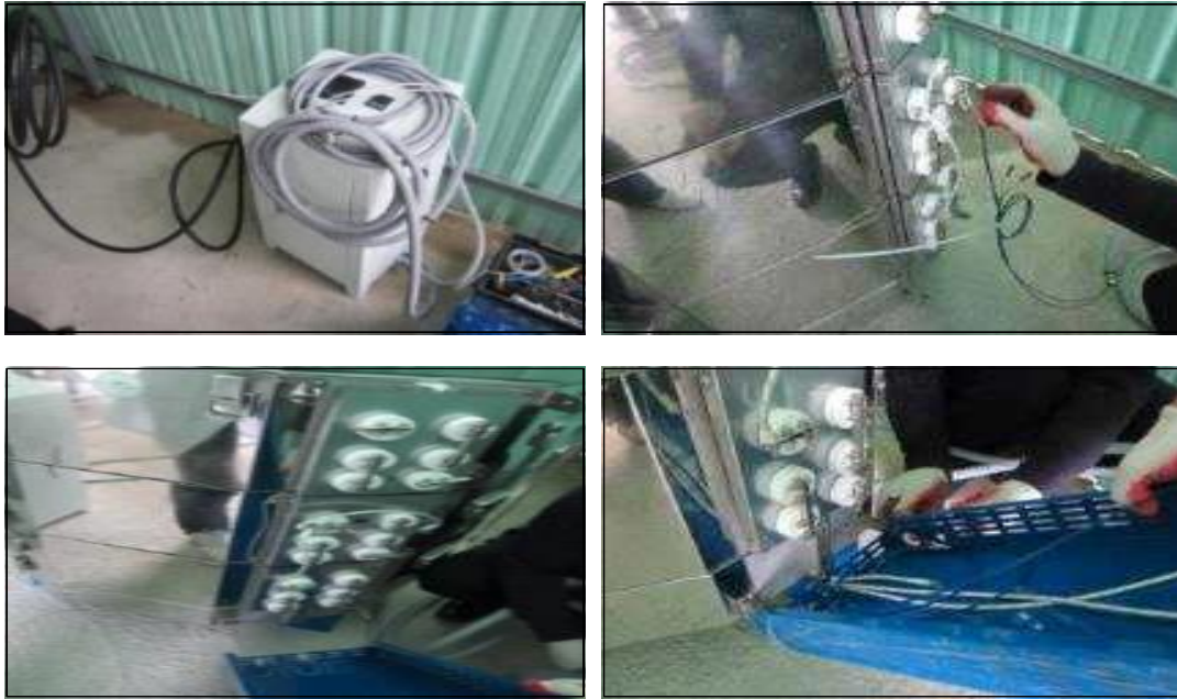
Fig. 3-422. 외부 컨트롤러 연결 및 안전판 설치.
