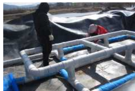
(통기관 보호망 설치)
