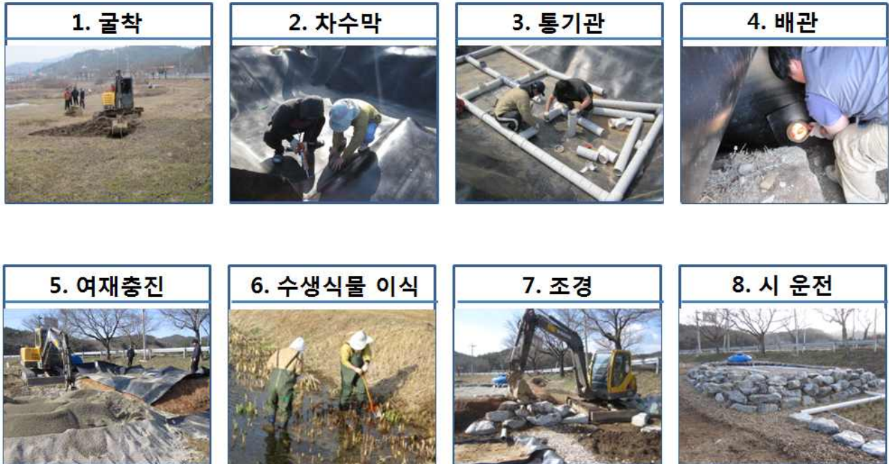
Fig. 3-266. 온실가스배출저감 자연정화시스템의 시공절차.
