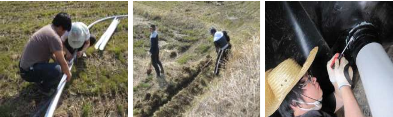
Fig. 3-271. 송수관 및 배관 작업.
