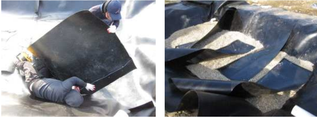
Fig. 3-267. 혐기성조 물 흐름막 구조 및 접합작업.
