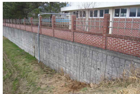
(원수 유출관 설치)
