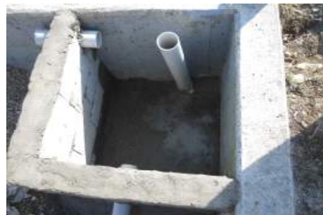
(방류수 배관 조절부 설치)
