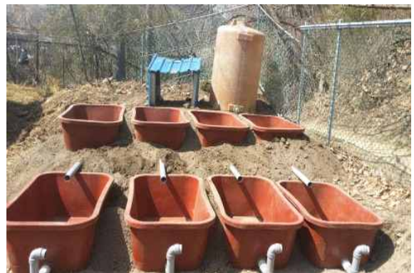
<호기성조 및 혐기성조 설치>
