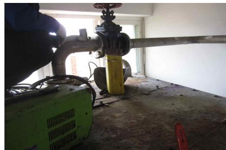
(유입수 밸브장치 설치)
