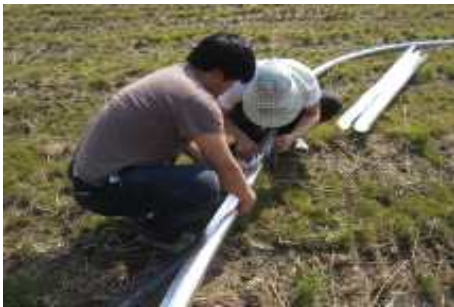
(유입관 보온제 작업)
