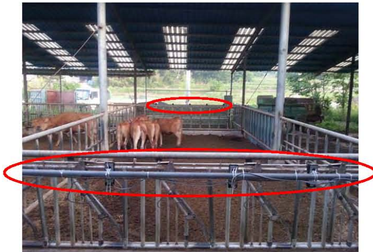
<그림 16> IR 센서의 설치 모습
