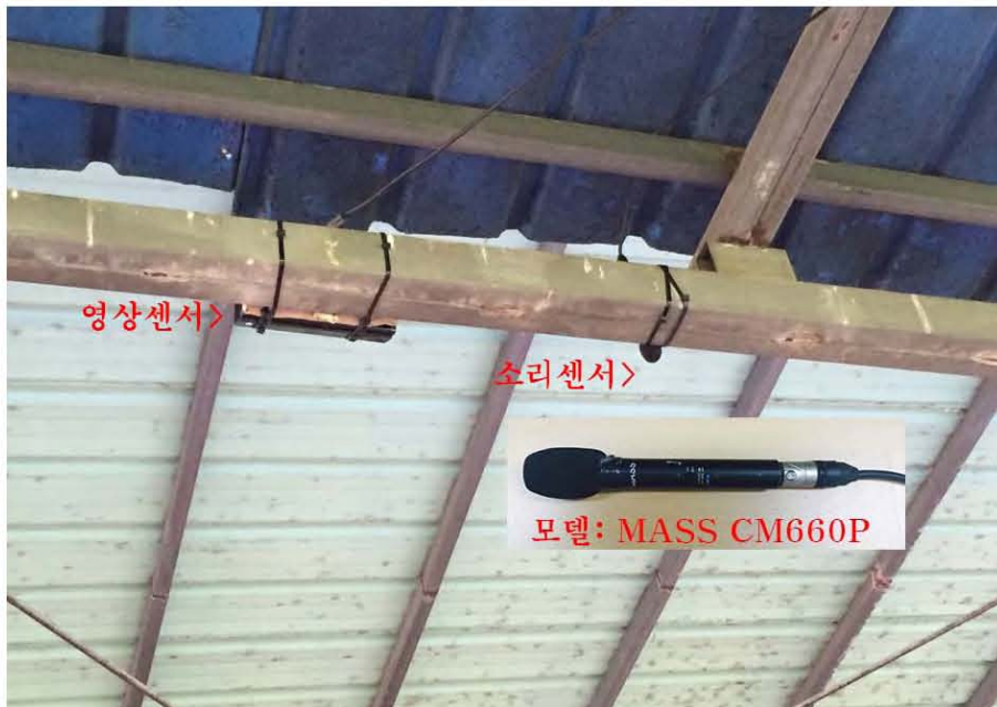
<그림 17> 경남 사천 축사의 천장에 설치한 센서
