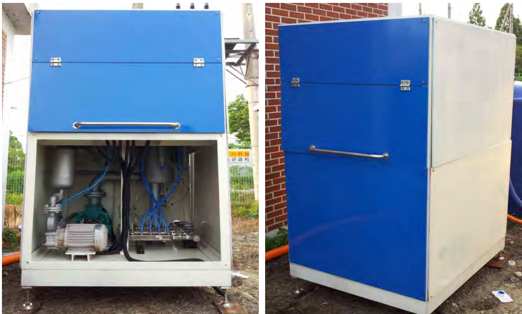
그림 3.12.43 시스템 현장 설치 전경
