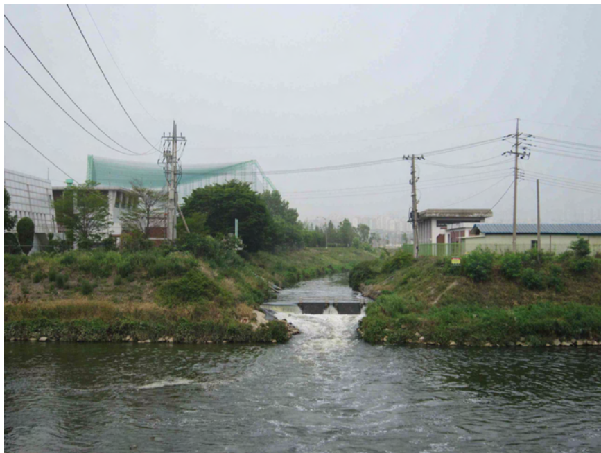
그림 3.1.6 수원하수처리장 방류구 및 병점양수장 전경
