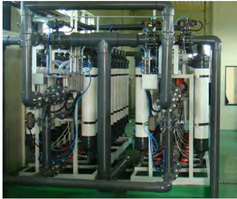
그림 3.10.13 Dead-End 및 Cross flow 막여과 설치사례
