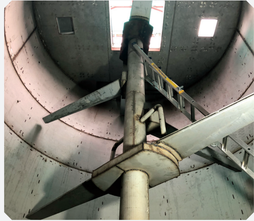
콤포스트 내부 교반날개 조립
