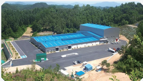
가축분뇨 자원화 시설 전경
