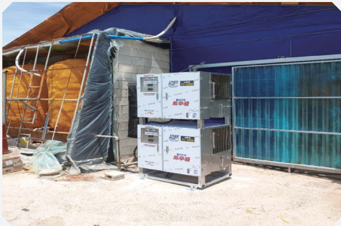
돈사 액비처리장 설치
