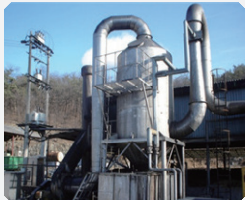
전남 보성군 가축분뇨 공공처리장
