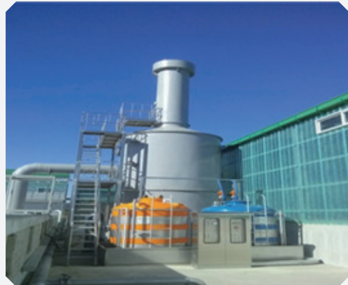
전남 보성군 가축분뇨 공공처리장
