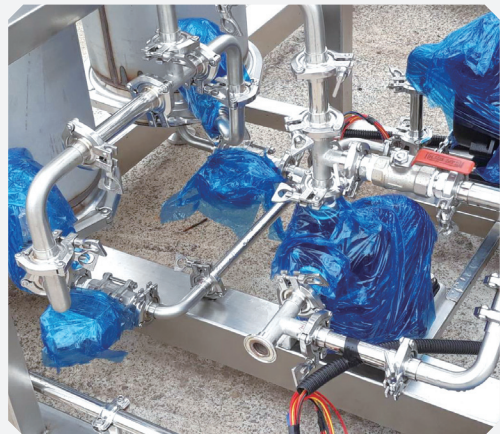
기계 배관 설치 사진
