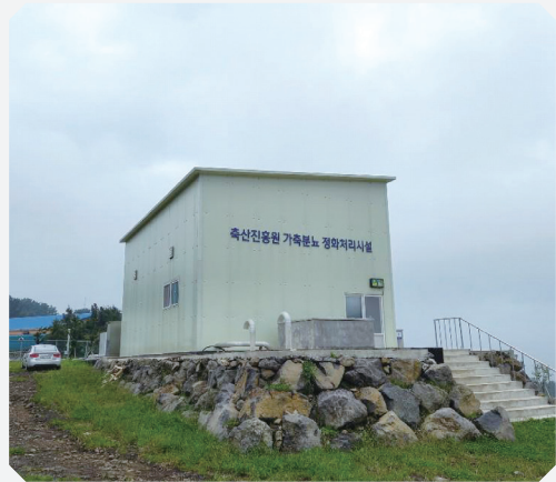
제주축산진흥원 기계실 전경
