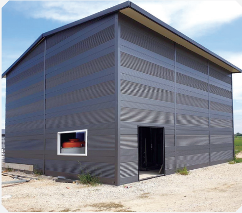
헤비팜 기계실 전경
