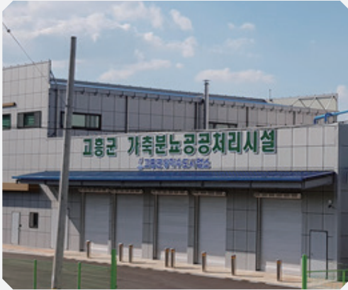
고흥군 가축분뇨 처리장
