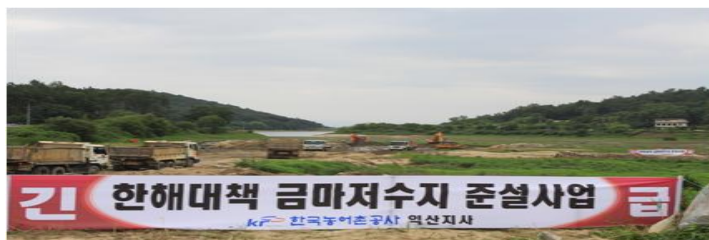
〈그림 2 - 37〉 저수지 준설 현장(익산 금마저수지,2012)
