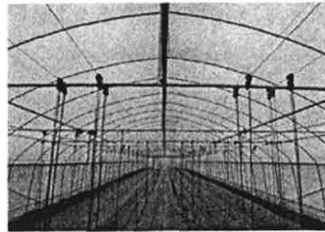
그림 22. 알루미늄 다겹 보온재 및 일반 부직포 설치 온실 전경
