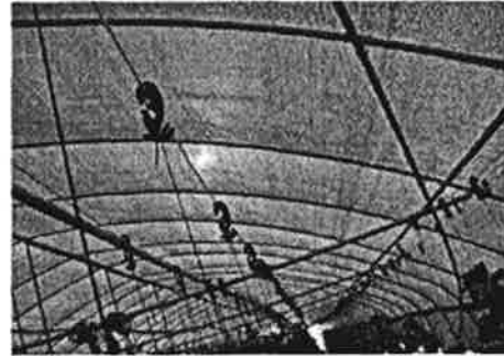
(F) 다겹 보온재의 천장 고정 작업 2
