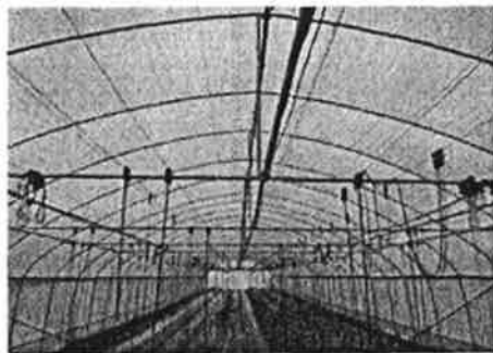
그림 22. 알루미늄 다겹 보온재 및 일반 부직포 설치 온실 전경
