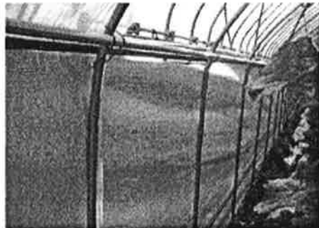
(C) 다겹 보온재의 측면부분 설치
