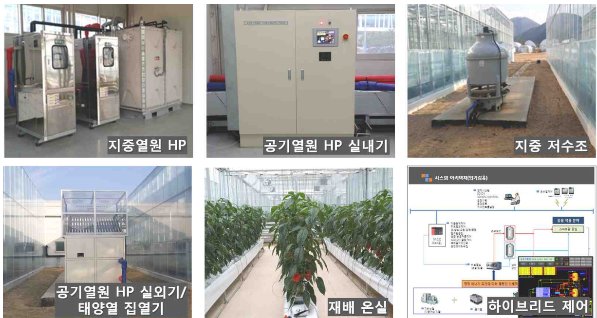
그림 31. 복합열원 이용 난방시스템 설치
