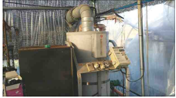
그림 11. 권취형 다겹보온커튼 및 등유온수보일러 (대조구)
