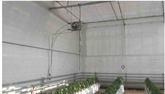
그림 4. 일반 보온커튼장치 설치장면(대조구)
