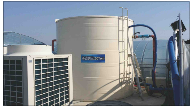
그림 12. 상부개방형 다겹보온커튼 및 축열식 공기열히트펌프(처리구)
