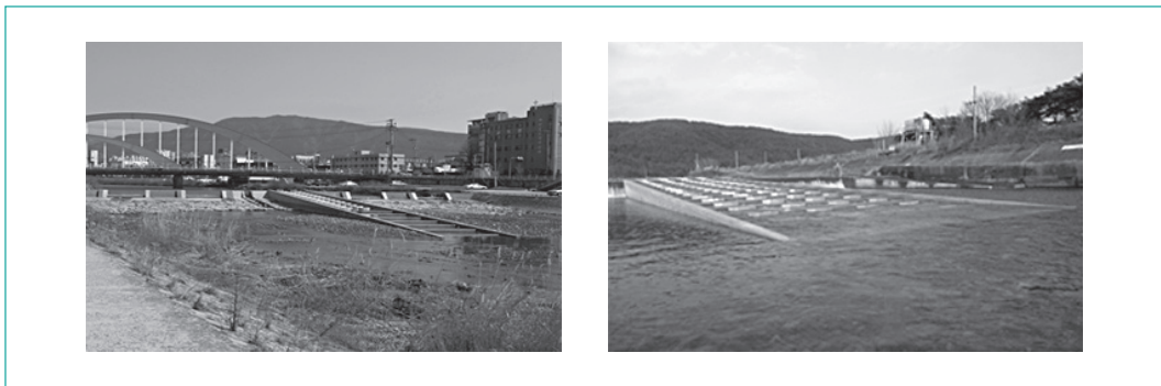
보령 대천천 어도 설치 현황
