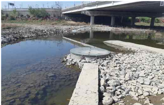
언양천에 양수시설 설치
