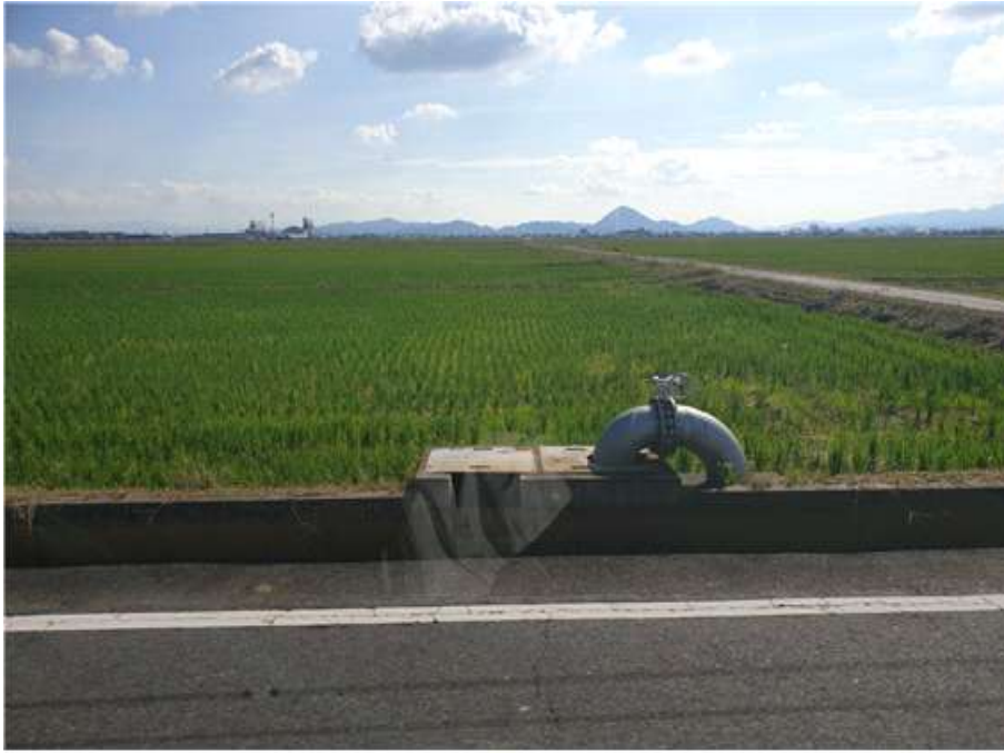
<시범지구 양수저류 관로 설치 전경>
