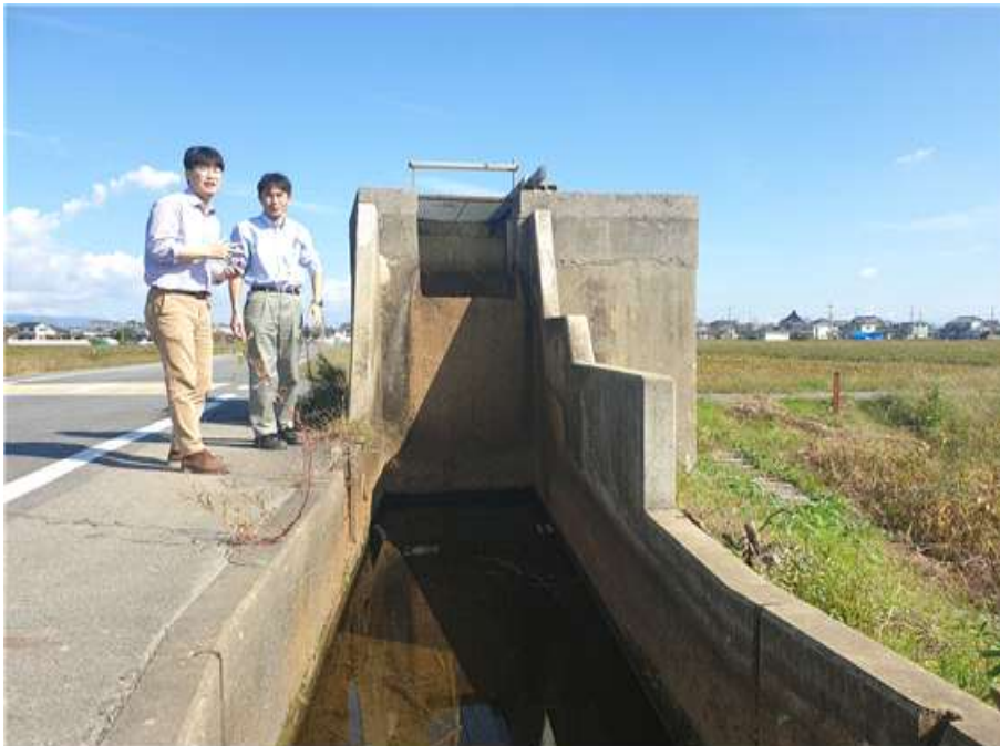
<토출부(토출조+낙차공) 설치 전경>
