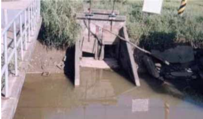
[그림 2-8-23] 인력으로 조작되고 있는 분수문 전경
