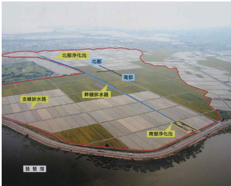
[그림 2-2-5] 비와호 인근 코노하마 순환관개지구 전경
