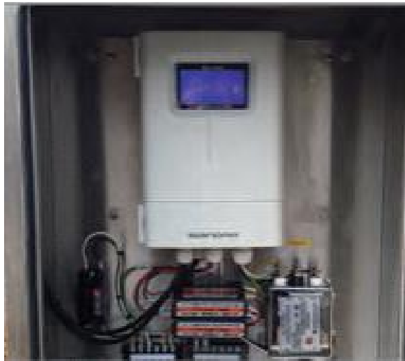
[그림 2-3-66] 대사지구 양수장 설치 수위계
