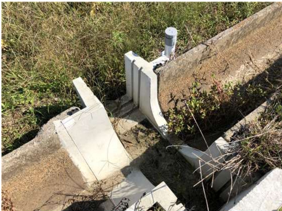
<용수로 개보수 후 현장 전경>
