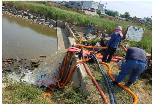
청지천 임시고압호스 양대보로 양수저류
