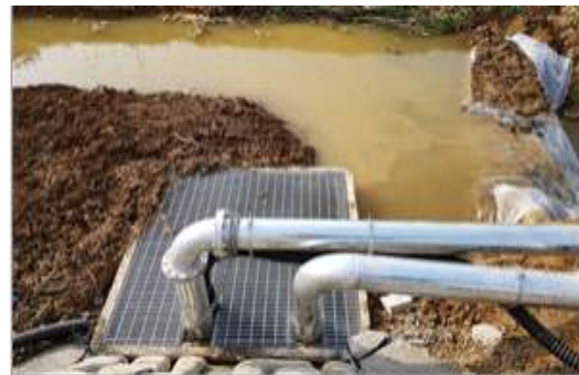
배수로에 간이양수장 설치
