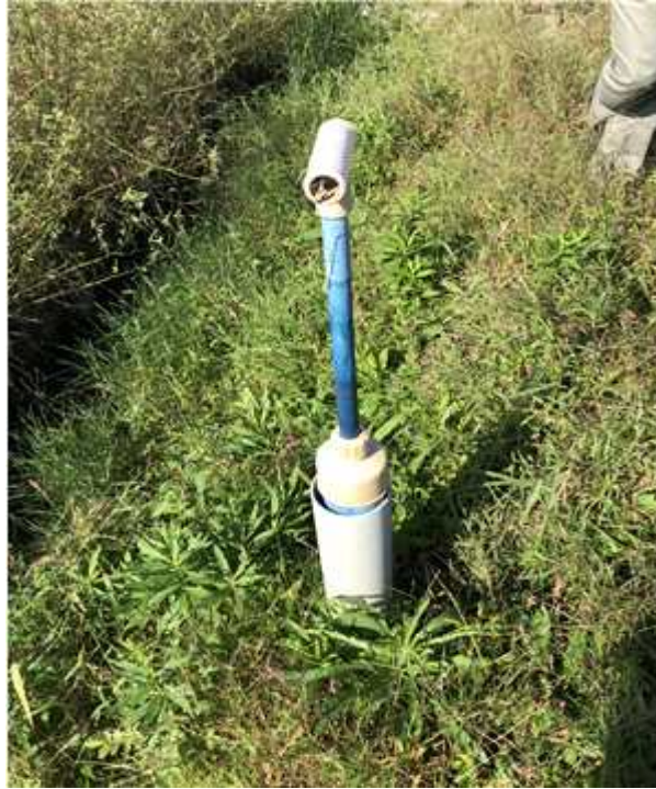
<맹암거 공기조절장치 설치 전경>
