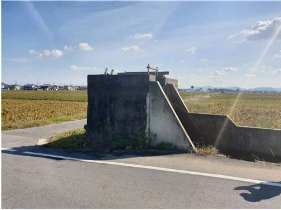
<시험지구 토출부 설치 전경>
