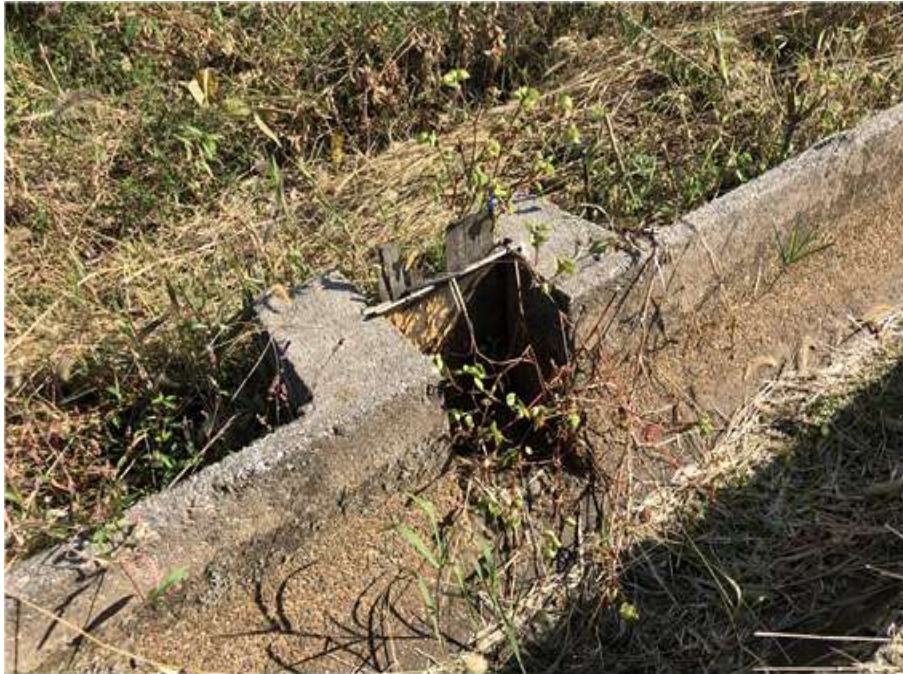
<용수로 개보수 전 현장 전경>
