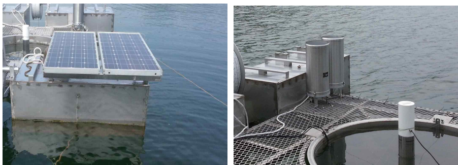
[그림 2-3-24] 전원공급시스템과 강수량계 설치
