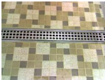
<그림4-10> trench drain 시공 예
