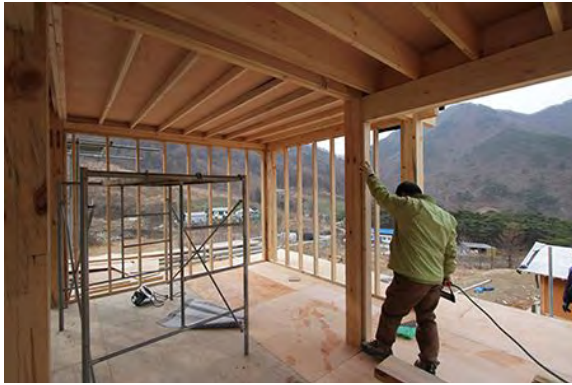
벽체 스타드 시공
