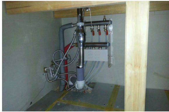
3층 분배기 설치 완료
