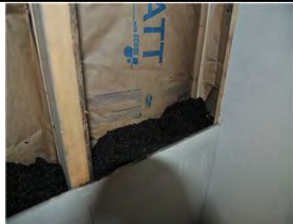
그림 76 실험방2 글라스울+훈탄 단열재 시공
