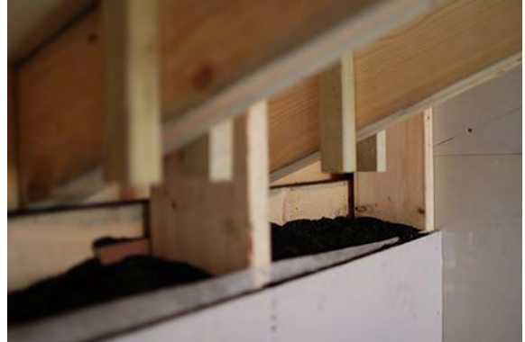
암면 단열재 위 왕겨 숲 단열재 시공
