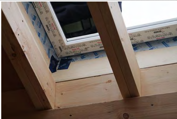
실내 기밀 테이프 시공
