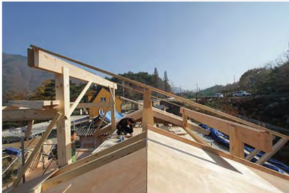
추가 기둥, 도리 시공 완료
