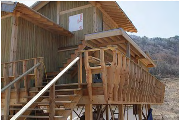
2층 계좌난간 설치 완료
