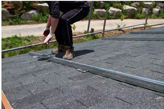
태양광 발전 시스템 모듈 설치를 위한 각파이프 설치
