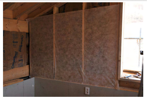
왕겨 숲 단열재 시공을 위한 부직포 시공
