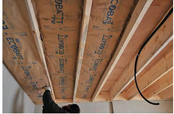
반자 틀 사이 유리면 단열재 시공
