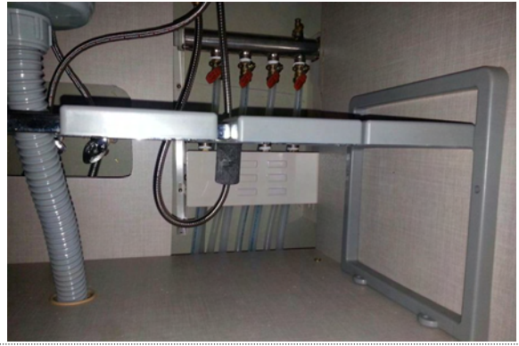
2층 분배기 설치 완료
