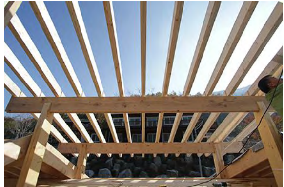
솥을 지붕 서까래 시공
