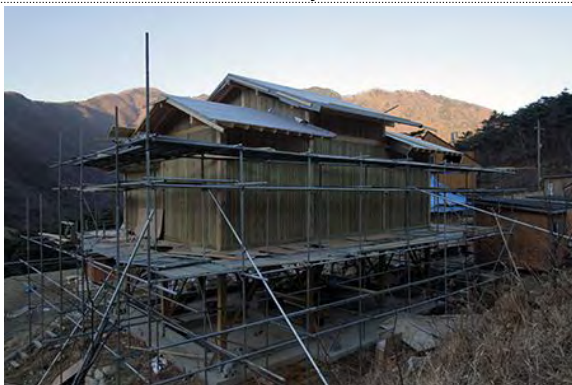
방부목 사이딩 시공 완료
