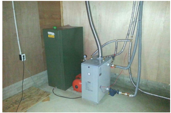
보일러 설치 완료
