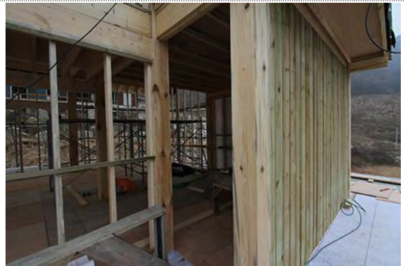
방부목 사이딩 시공
