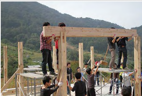
보, 도리 시공
