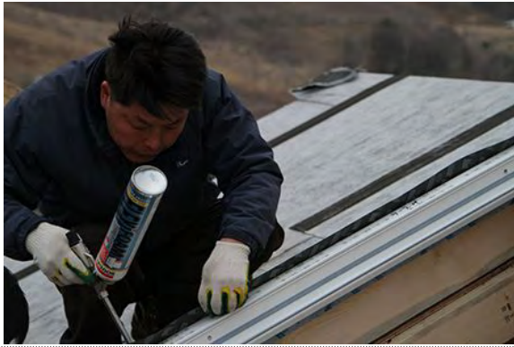
천창 창틀 설치 후 폼 충전
