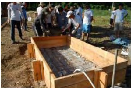
(7) 기초 거푸집 조립
