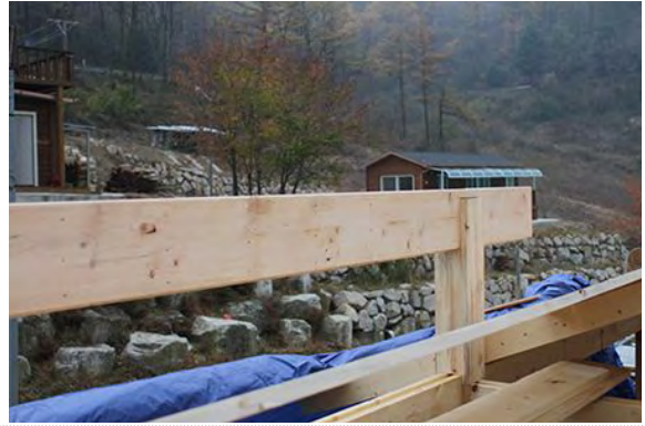
추가 기둥, 도리 시공
