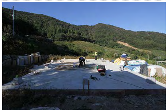
콘크리트 기초패드 타설
