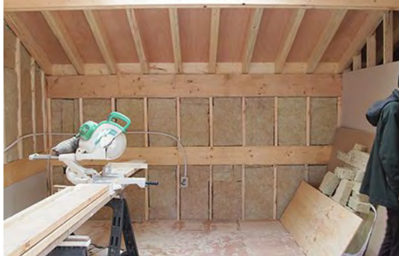
암면 단열재 시공
