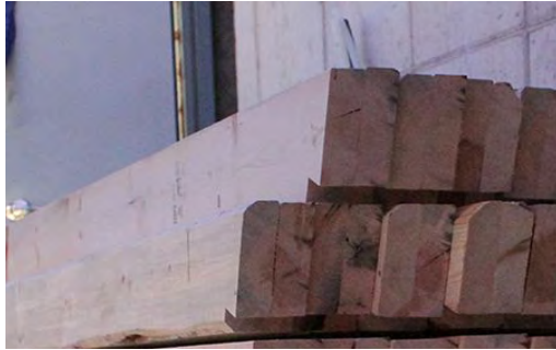
그림 55 경량목구조 부재로 제작한 서까래
