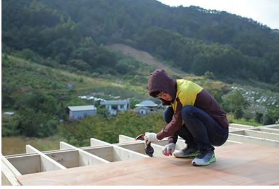
2층 바닥 합판 덮기
