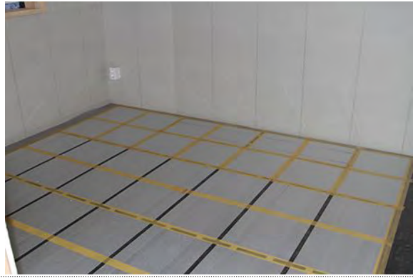
건식 바닥 난방 장치 설치 완료
