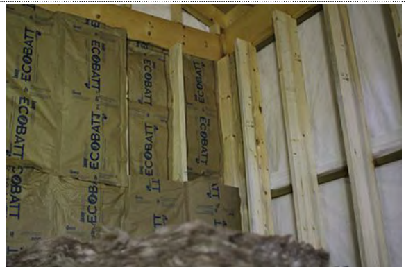
유리면 단열재 시공
