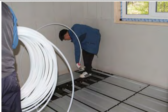
온수 파이프 시공
