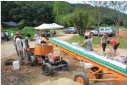
컨베이어를 이용한 재료 투입
