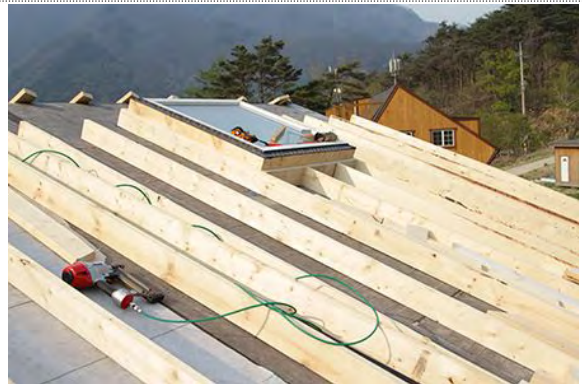
지붕 단열을 위한 뒯서까래 시공
