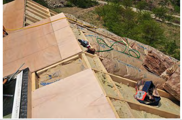
단열 시공 후 합판 덮기
