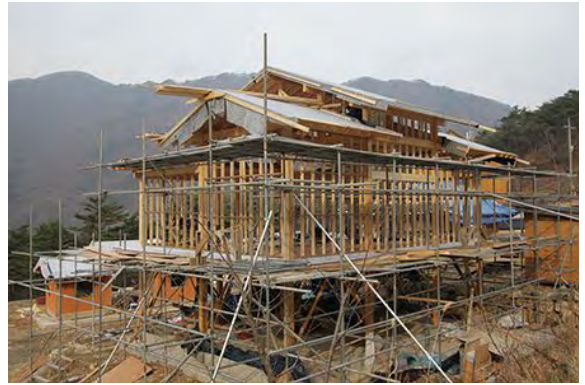
벽체 스타드 시공 완료
