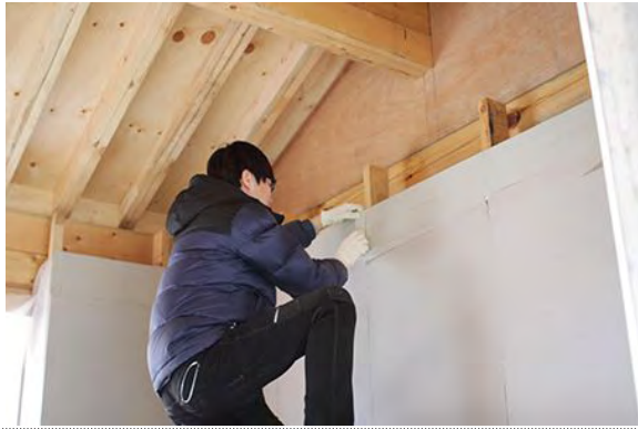
왕겨 숲 단열재 시공을 위한 부직포 위 석고보드 시공
