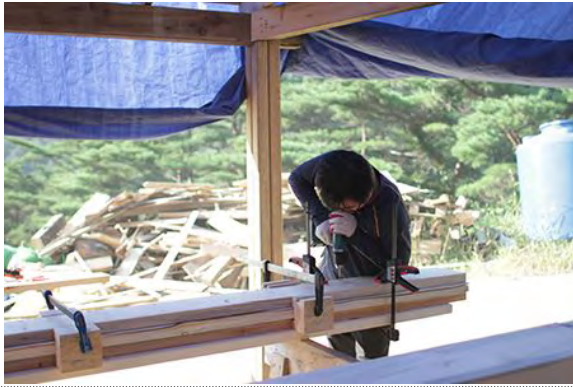
경량 목구조 목재 조립(보, 도리)
