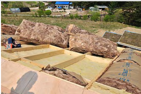
암면 단열재, 유리면 단열재 시공 및 합판 덮기
