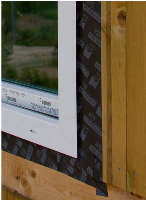
그림 57 Test-bed 기밀테이프 시공
