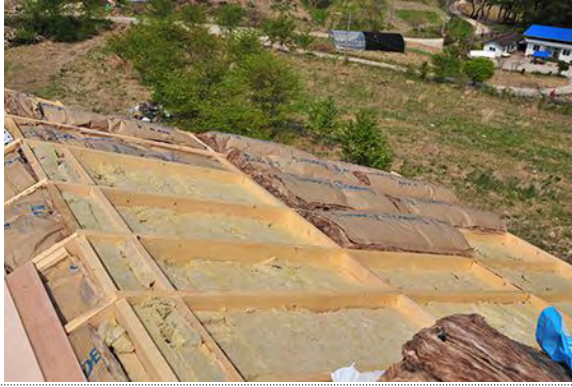
암면 단열재, 유리면 단열재 시공
