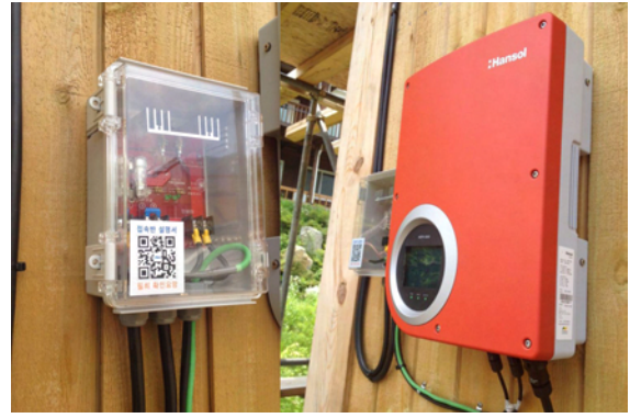
그림 67 태양광 발전 시스템 인버터
