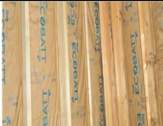
그림 75 실험방1 글라스울 단열재 시공
