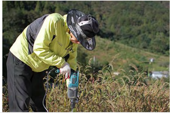
주춧돌에 앵카 볼트 설치
