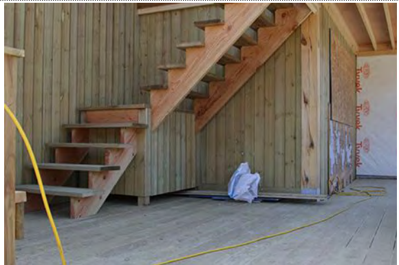
3층 진입 계단 설치
