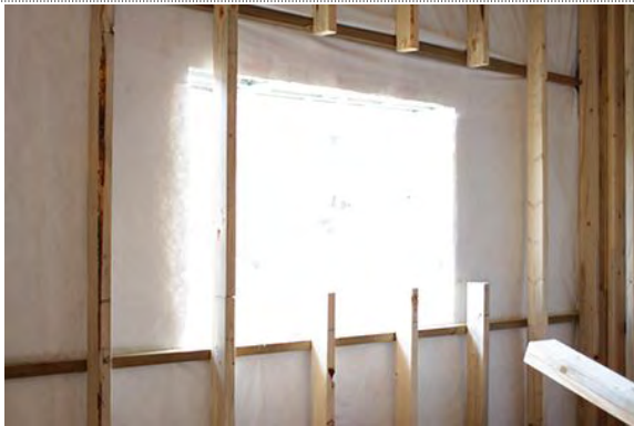
투습 방수지 Tyvek 시공
