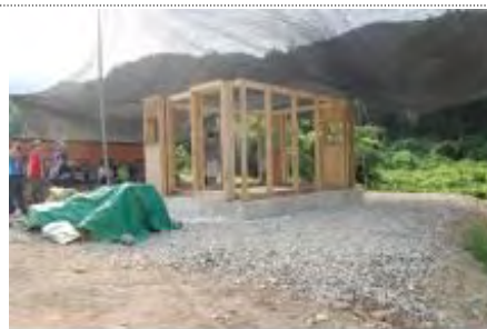
가이드 상부 부재 연결
