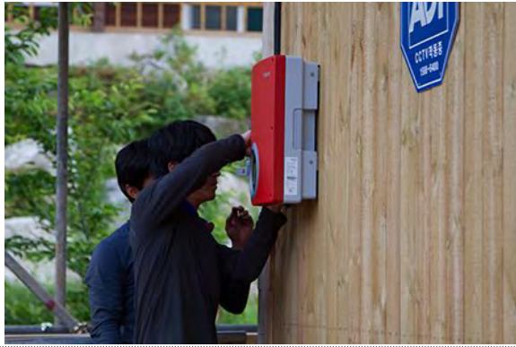
인버터 설치 및 전선 연결
