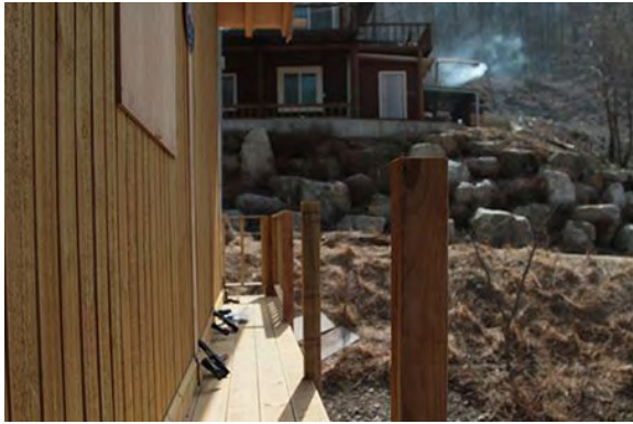
2층 난간 기둥 설치
