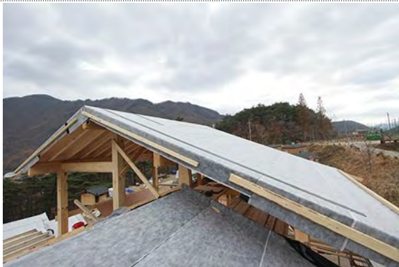
합판 위 방수시트 시공
