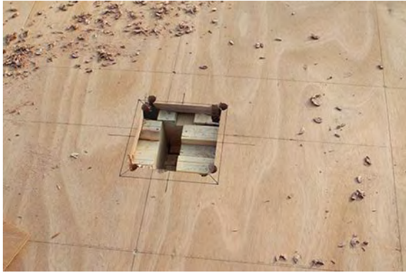
2층 기둥을 잇기 위한 기초 작업
