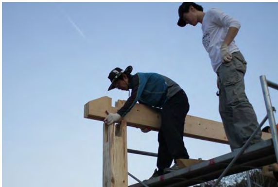
2층 보 시공
