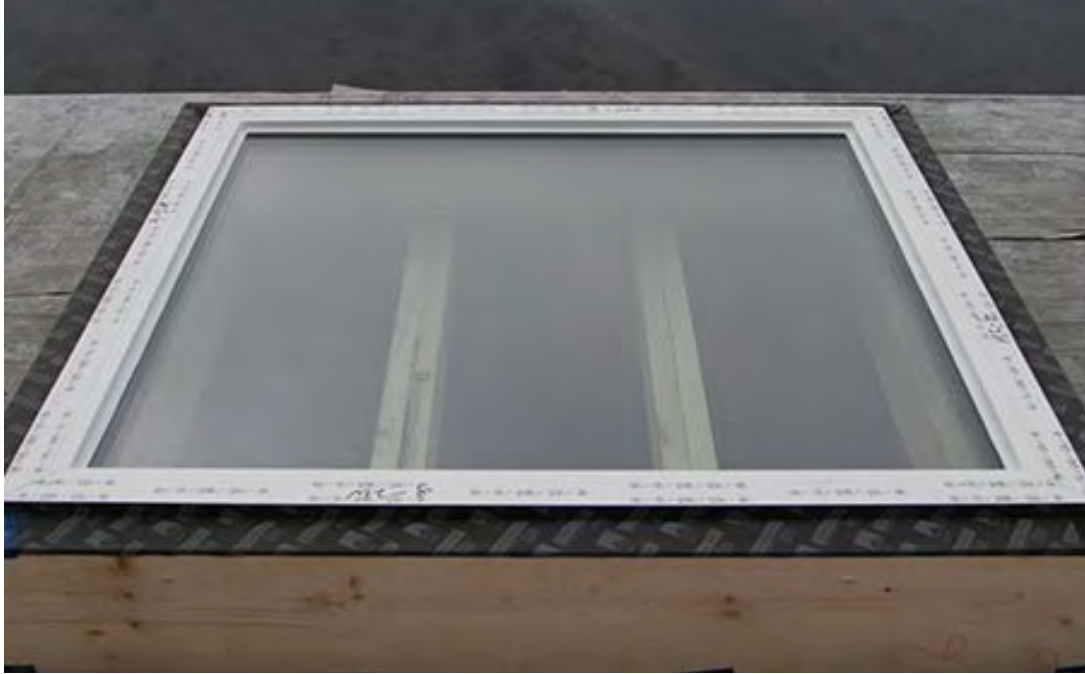
그림 63 Test-bed Skylight 시공
