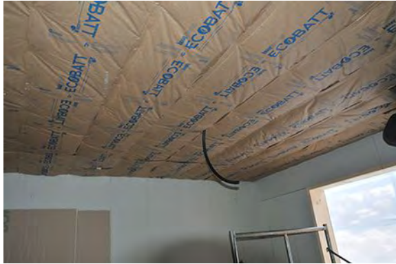
천장 유리면 단열재 시공 완료
