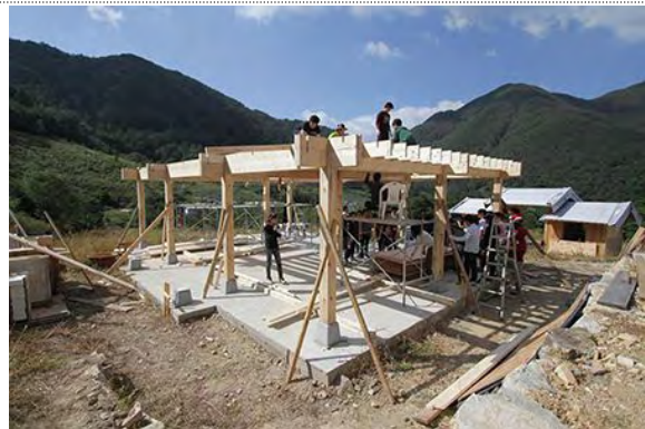
1층 구조체 시공 완료
