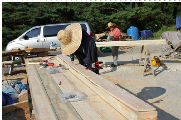
경량 목구조 목재 조립 후 서까래 가공
