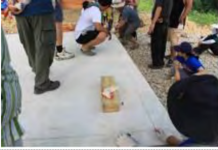
내벽 먹줄 시공
