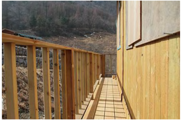
2층 난간 설치
