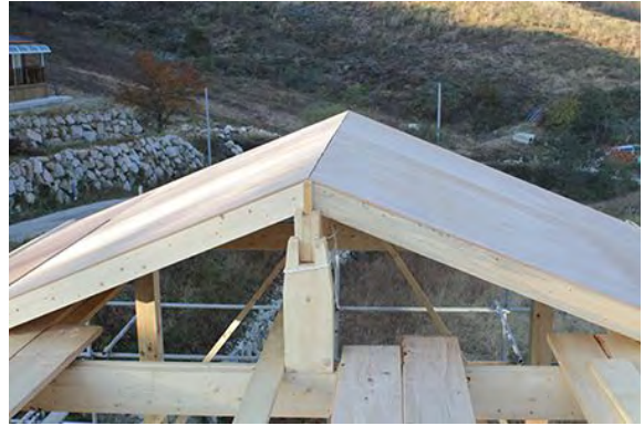
합판 덮기 시공
