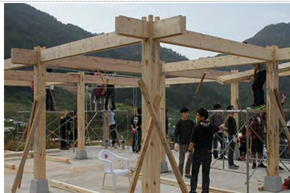
보, 도리 시공 완료
