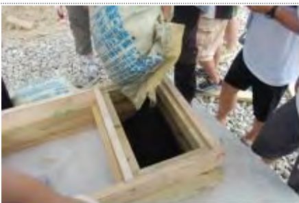
창문틀 하부 단열재 채움
