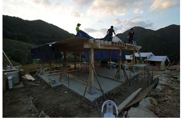
2층 바닥 합판 덮기 시공 완료
