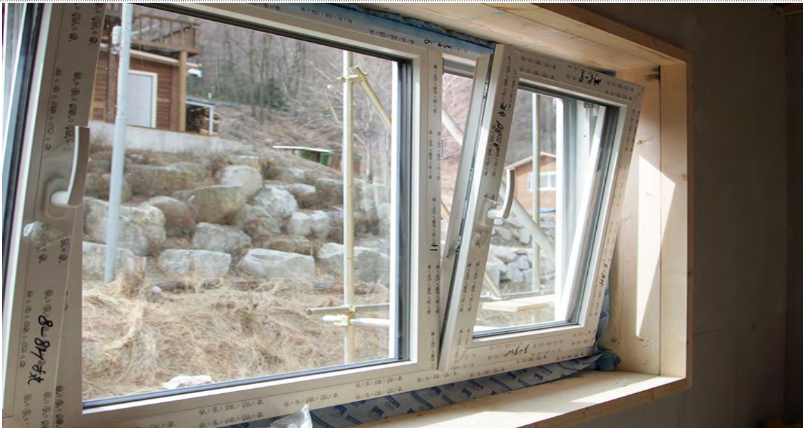
그림 62 시스템 창호 설치 완료
