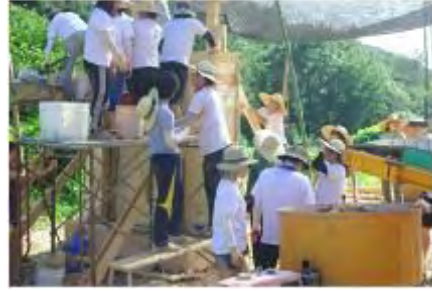
(12) 고강도 흙다짐 시공
