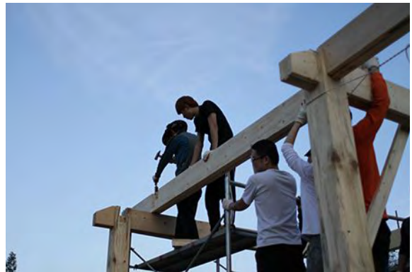
2층 도리 시공
