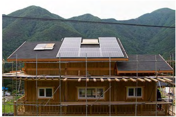
태양광 발전 시스템 장치 설치 완료
