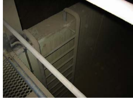
<콘크리트 타설에 의한 칸막이>
