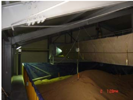
<Unit cooler 및 air sock duct시스템>
