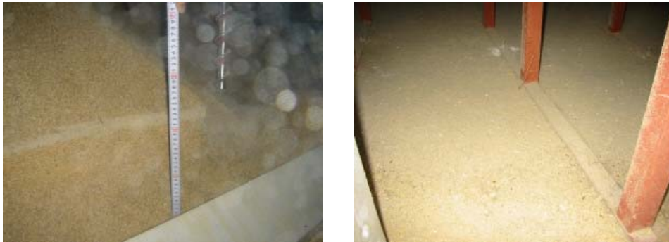
그림 3-1-2. 원형철제빈 내부 수직오거로 교반되지 않은 부분과 공기압력실 청소상태
