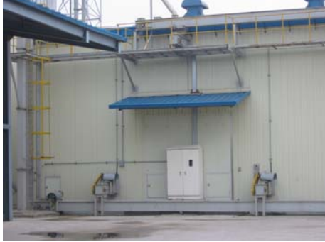
<산물이송설비에 의한 투입시설>
