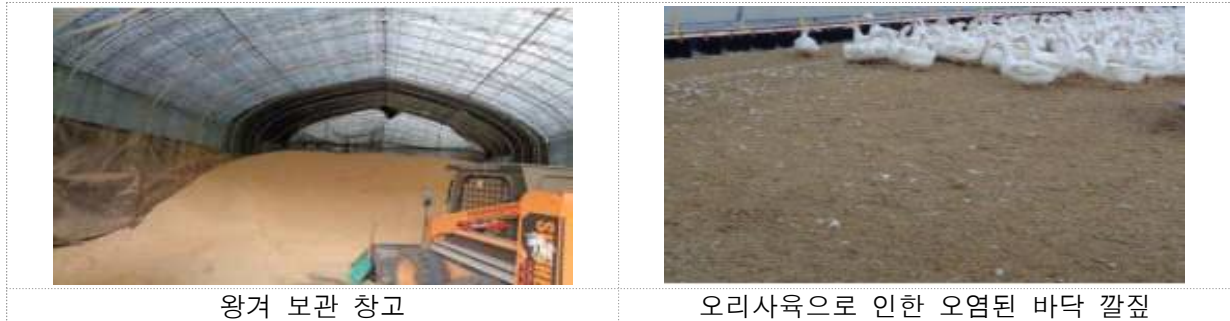
[그림 3-10] 바닥 깔짚용 왕겨 보관 상태 및 축사 바닥관리 상태
