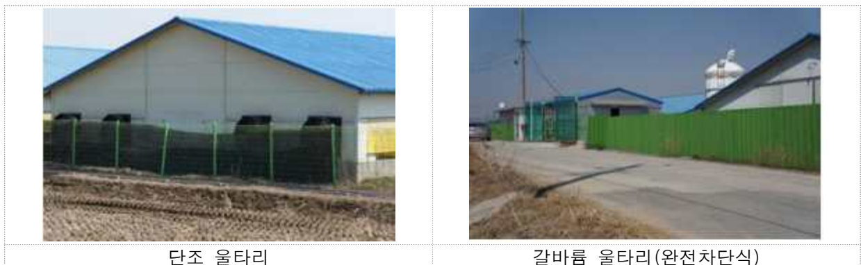
[그림 3-8] 축사 주변 울타리 설치
