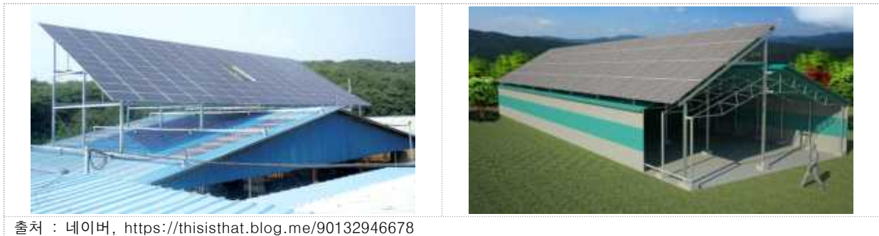
[그림 3-14] 축사 지붕 위 태양광 발전설비 설치 예(좌)와 조감도(우)
