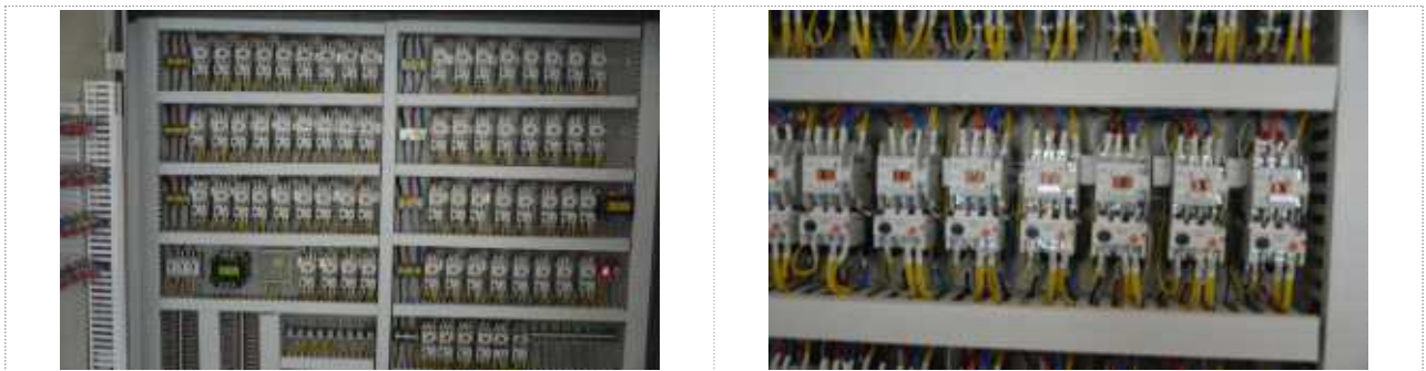
[부록 그림-32] 마그네트 스위치(오버로드 프로텍트 장치 부착)
