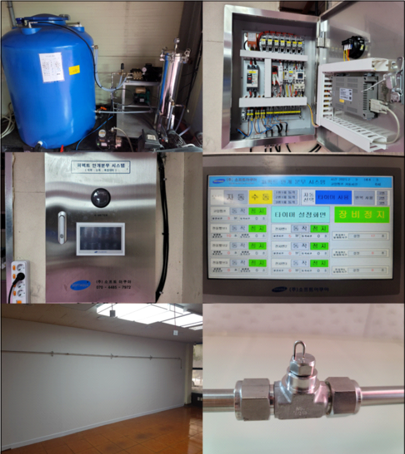
그림 2-1-28. 노즐시스템 전체 구성 및 노즐 확대 사진
