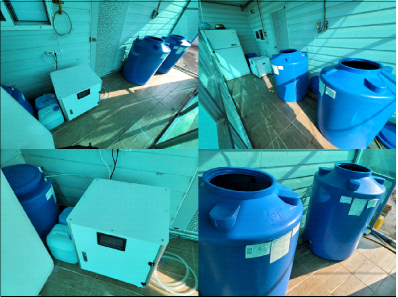
그림 2-1-30. ○○종계농장 소독수 생성장치 설치 사진
