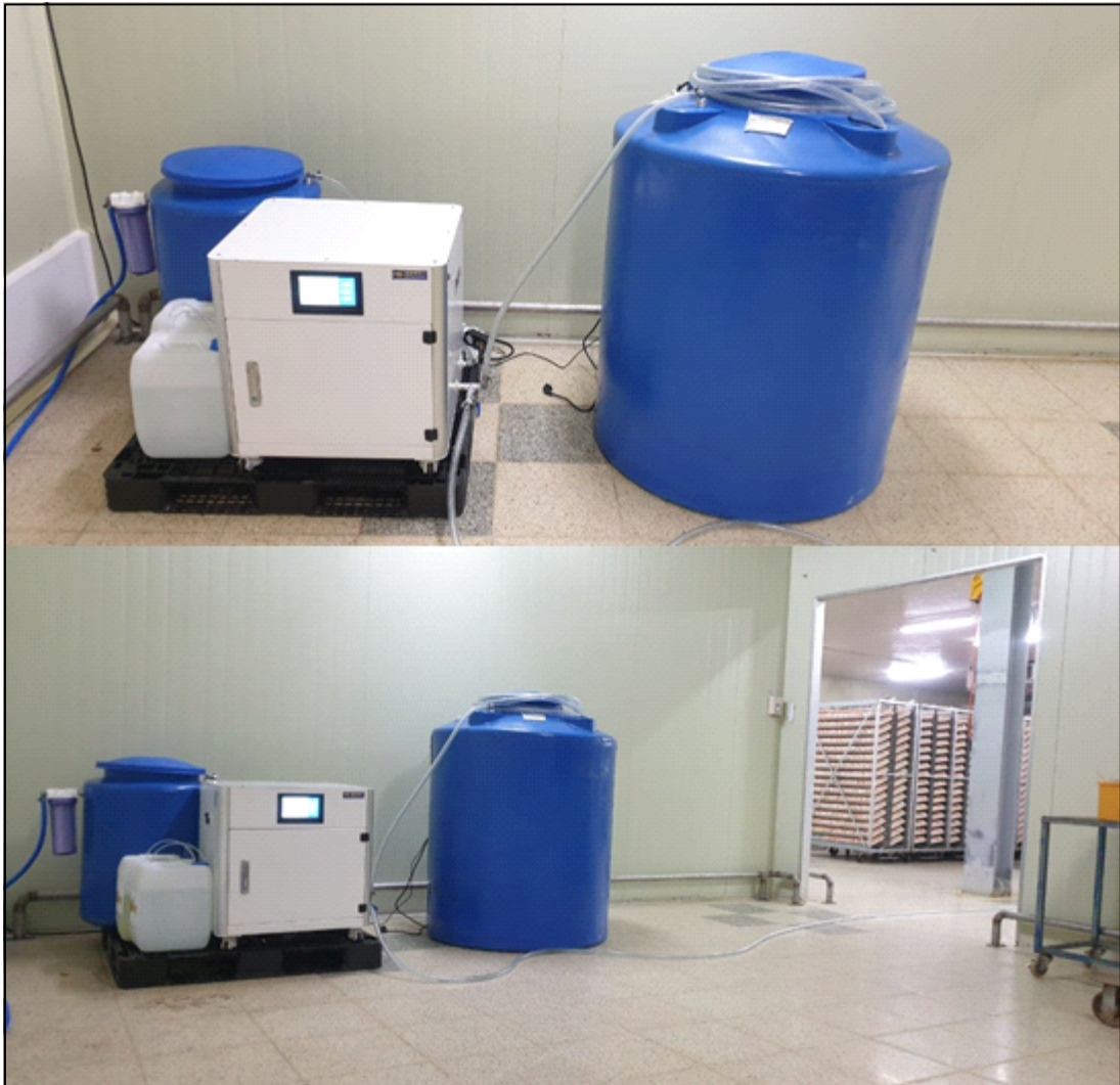
그림 2-1-33. ○○부화장 소독수 생성장치 설치 사진
