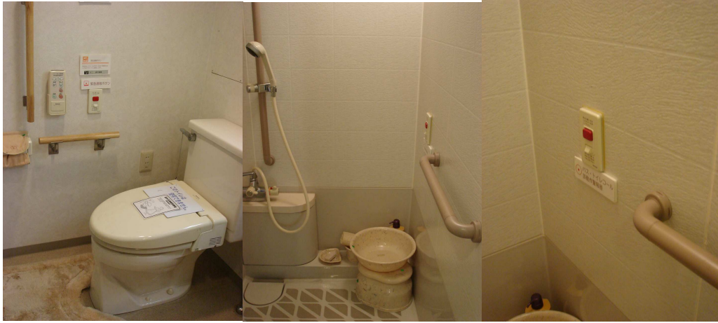
<위생설비의 핸드레일설치 및 비상벨 설치>
