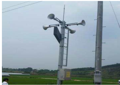
<그림 44> 방송·경보 시설 설치 사례(현장조사 결과)
