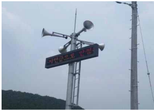
<그림 44> 방송·경보 시설 설치 사례(현장조사 결과)
