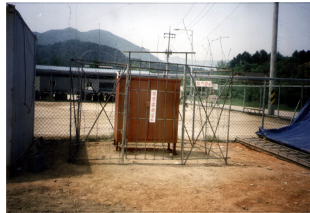
<그림 7-48> 화약고 설치
