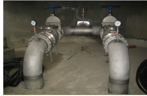
<그림 7-76> 내부배관 설치
