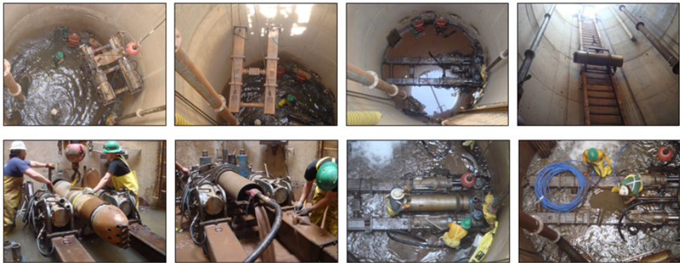
<그림 7-12> 해외 대구경 수평공 설치를 위한 작업 절차 전경
