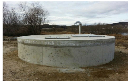
<그림 7-71> 슬라브 설치 완료
