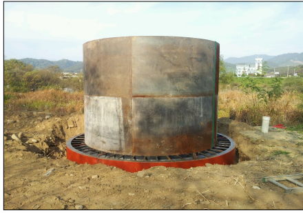
<그림 7-52> 내부 거푸집 설치
