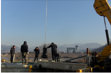
<그림 7-75> 수중모터 설치
