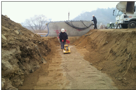
<그림 7-73> 터파기, 모래부설 및 다짐
