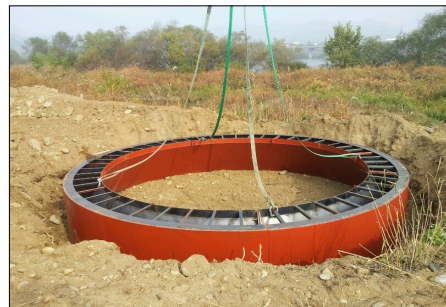
<그림 7-51> 슈 설치 전경
