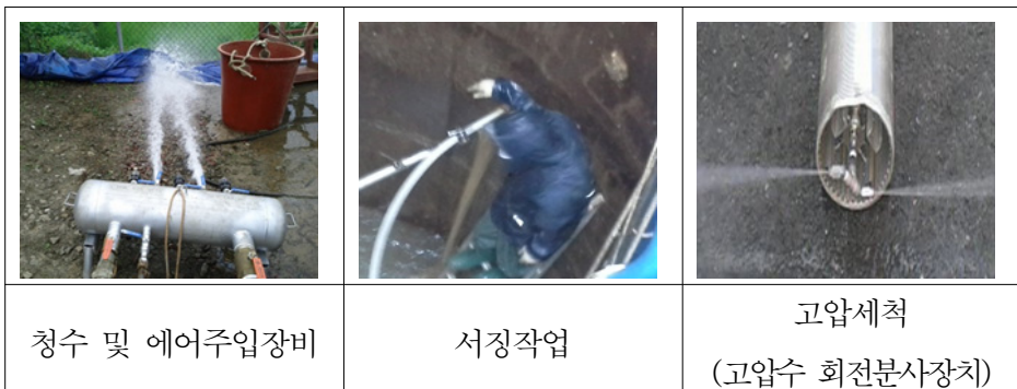
<그림 5-3> 서징 및 고압세척 장비
