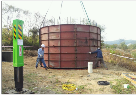
<그림 7-54> 외부거푸집 설치
