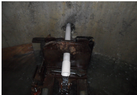
<그림 7-64> 우물자재 설치
