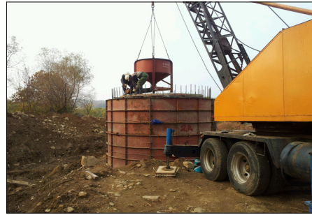
<그림 7-55> 콘크리트 타설
