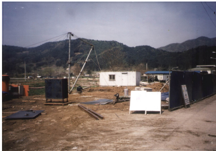
<그림 7-47> 작업장크레인 설치
