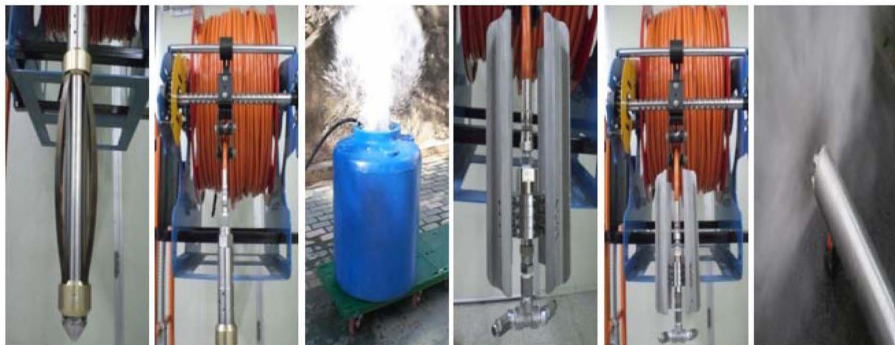
< 고압충격발생기 및 고압세척기 시공 사진 >
