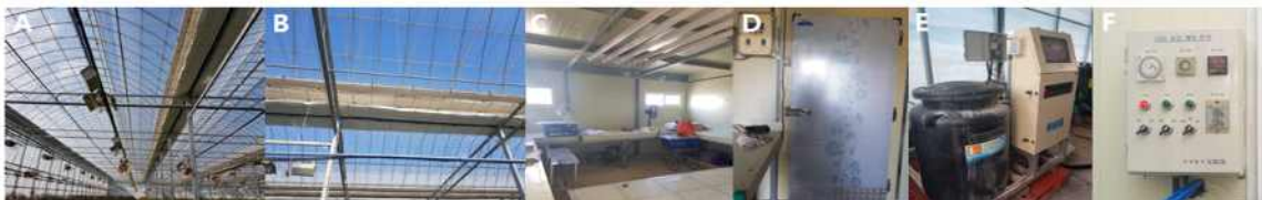
그림 51. 전라남도 강진군 스마트팜 내부 시설 (A, B; 스크린 및 창, C; 작업장, D; 저온고, E; 양액조절장치, F; CO 2 공급 장치)
