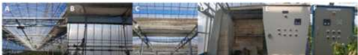
그림 52. 전라남도 강진군 관행농가 내부 시설 (A, B; 천창 및 측창, C, D; 보온 및 차광 스크린, E; 스크린 조절장치, F; 난방조절장치)
