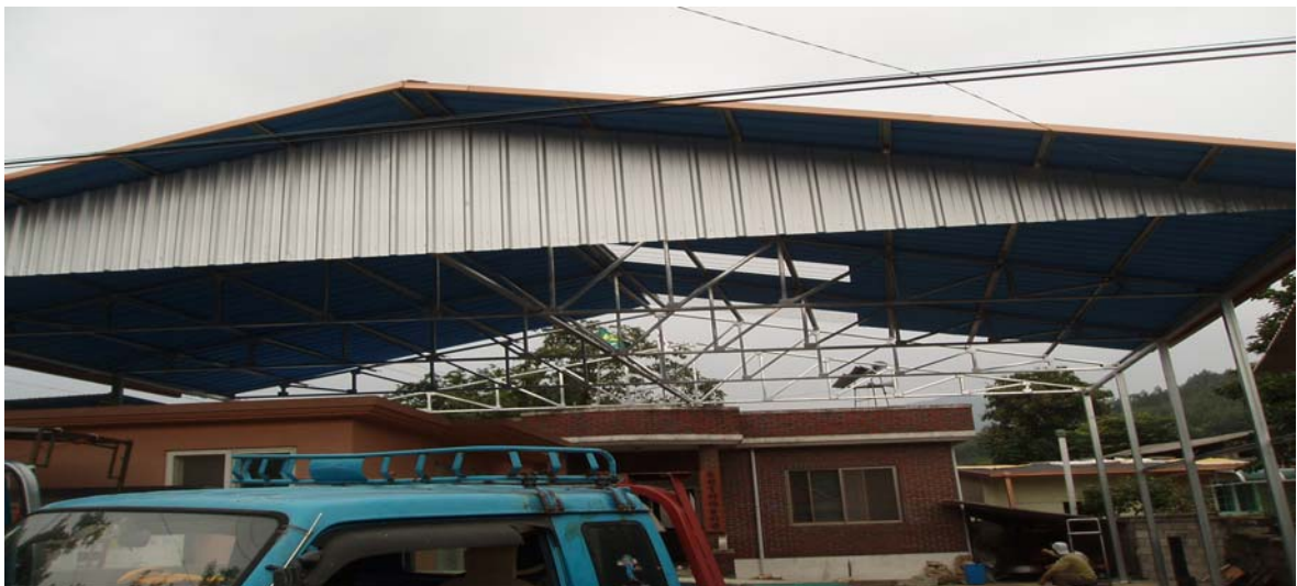
공동집하장 설치 장면
