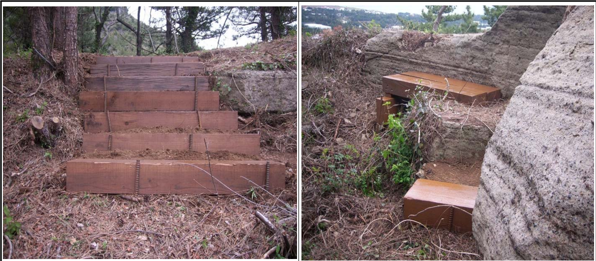
올레코스(군산) 추가 개설에 따른 계단 설치
