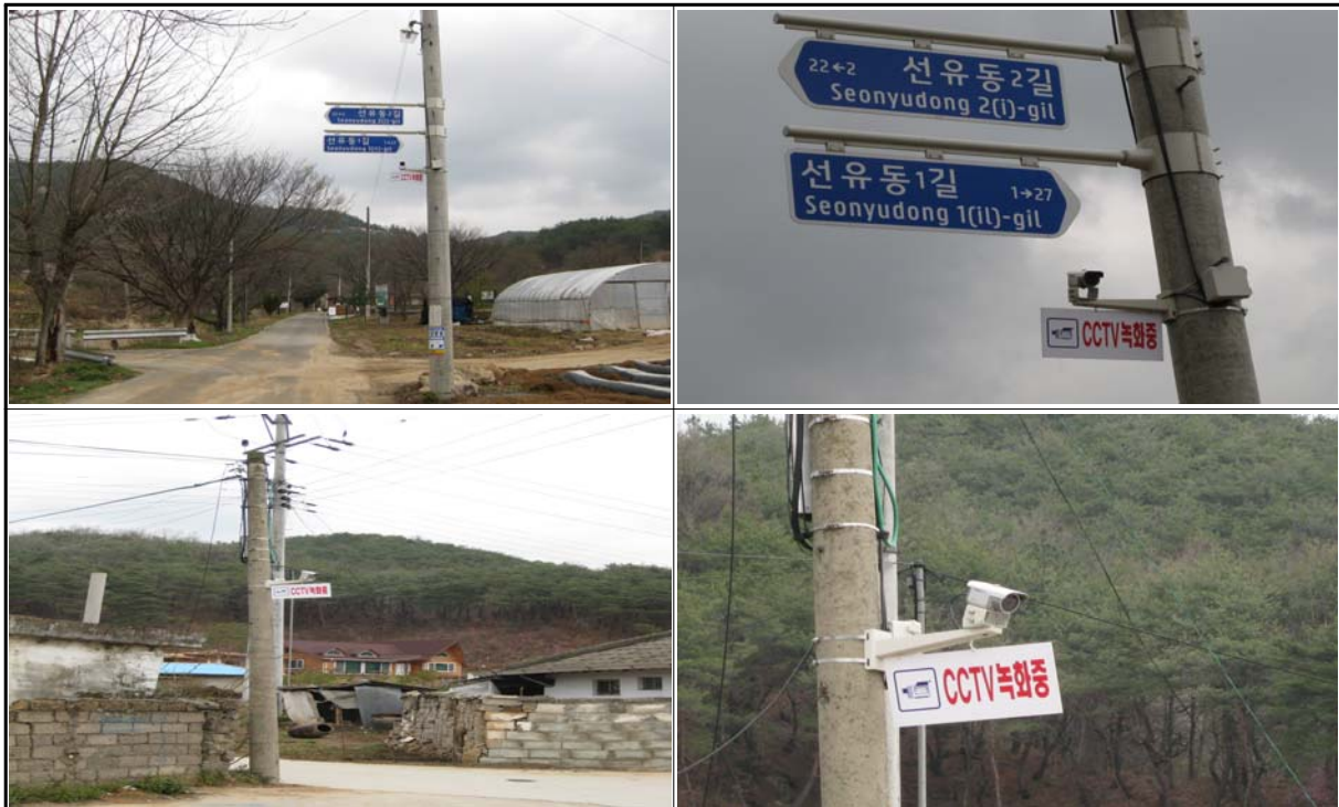
CCTV 설치 (2대)
