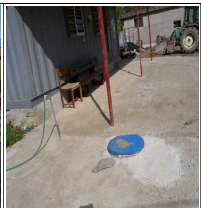
수도 계량기 설치
