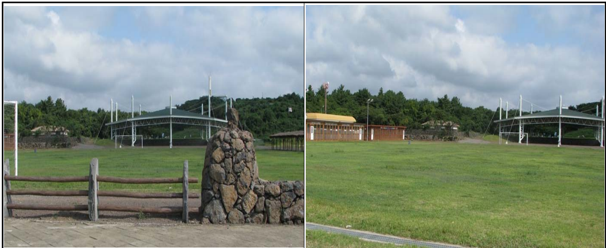
무형 민속 상설공연장 지붕공사 완료
