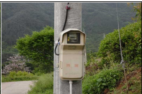
안테나 설치 전기 설비 설치
