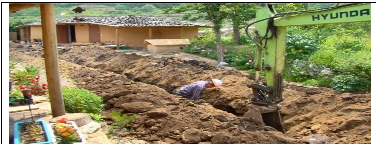
마을 상수도 공사
