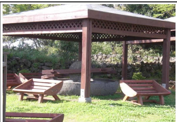
테마공원 정자 및 연자방아 설치
