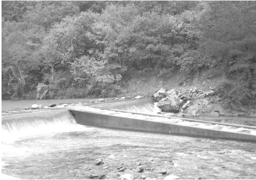
〈그림 33〉 콘크리트로 만든 일반적인 계단식 어도
