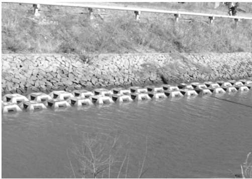
〈그림 35〉 인공블록 이용한 어도
