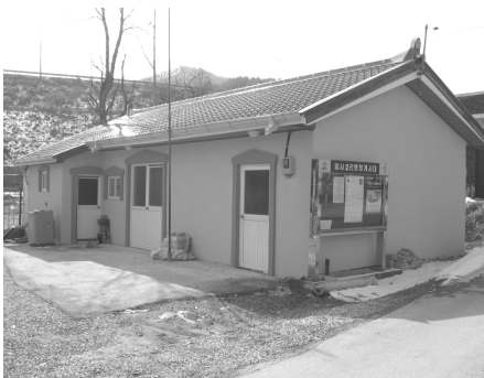
<그림 104> 경사지붕의 설치
