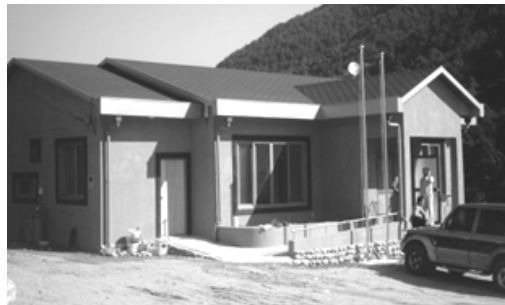
〈그림 66〉 콘크리트로 건조하고 외벽은 황토
