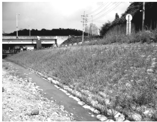
〈그림 32〉 자연석을 이용한 계단호안
