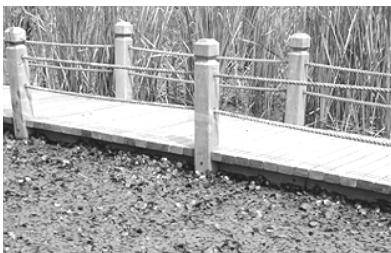
<그림 41> 목재 난간을 설치한 데크 (파주 헤이리)
