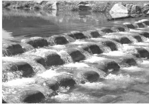
〈그림 34〉 자연석 블록을 이용한 계단식 어도
