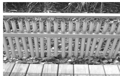
<그림 42> 소리철 난간을 설치한 데크 (파주 헤이리)
