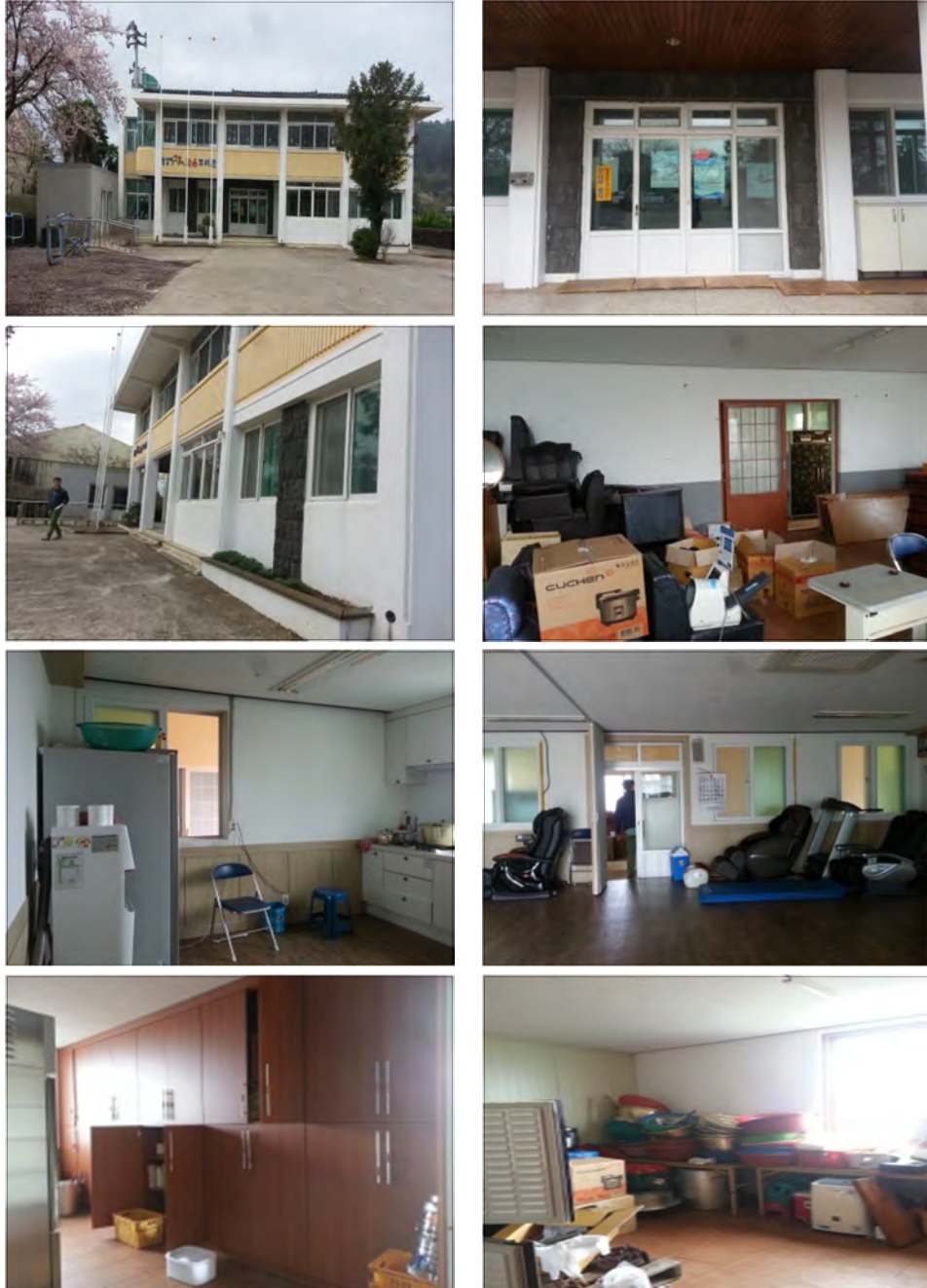
<대지 주변현황 및 기존 시설 내·외부>
