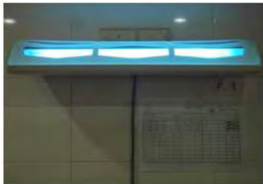
그림 4-39 포충등 설치
