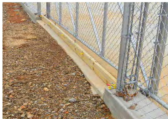
그림 4-13 방접선, 차단막, 마우스트랩 설치 그림 4-14 울타리 콘크리트 옹벽 설치
