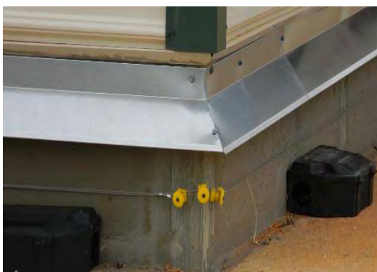
그림 4-13 방접선, 차단막, 마우스트랩 설치 그림 4-14 울타리 콘크리트 옹벽 설치
