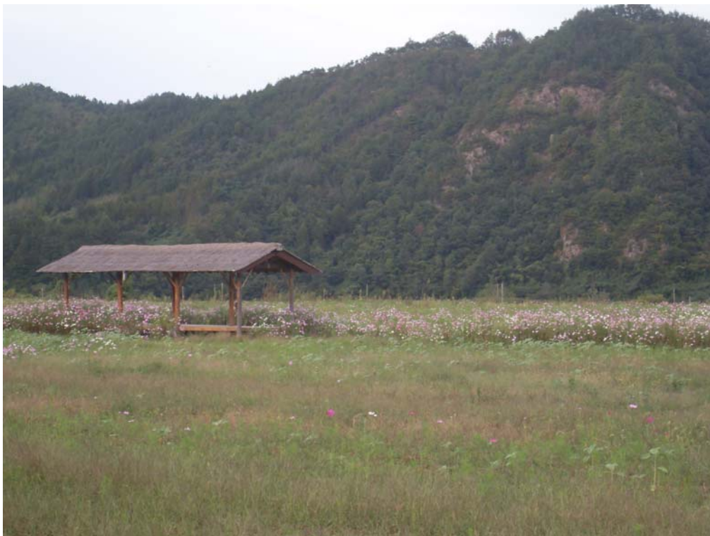
원두막 설치 전경
